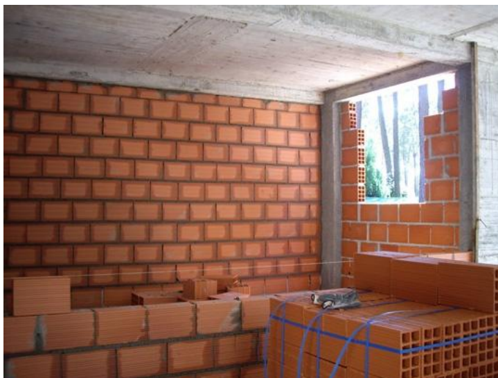
Fig. 2.1 – Exemplo de uma parede de alvenaria de tijolo furado cerâmico (autor desconhecido).
