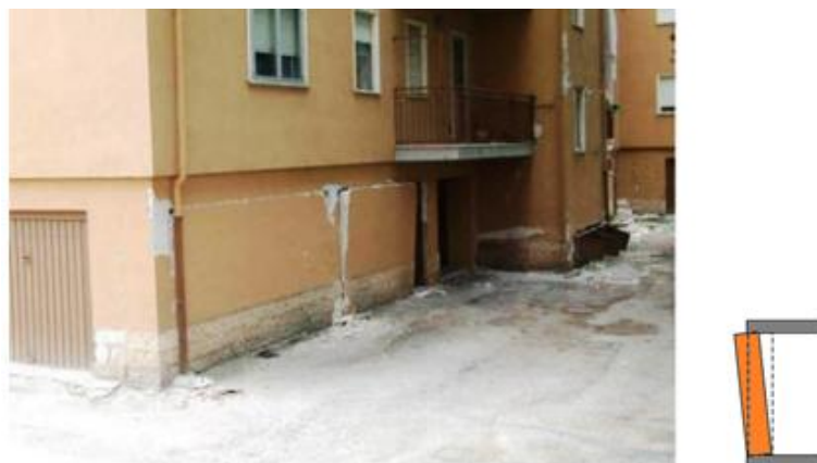
Fig. 3.18 - Deslocamento do painel de alvenaria para fora do plano, sismo de L'Aquila (2009) (Braga, et al. , 2010).
