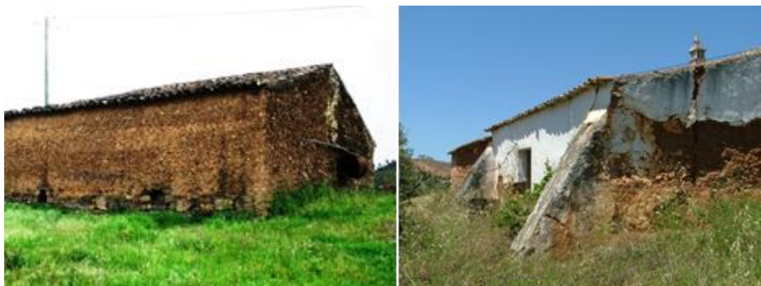
Figura 4: Construções tradicionais em taipa, no concelho de Silves
