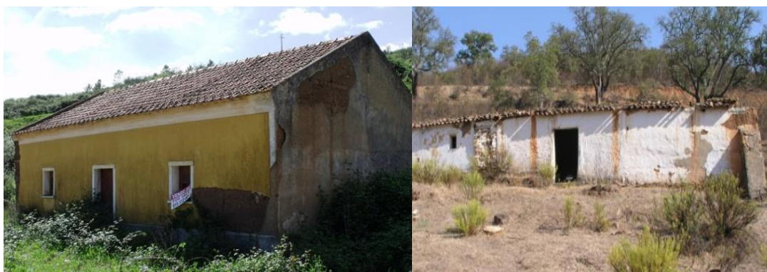
Figura 5: Construções tradicionais em taipa, no concelho de Monchique
