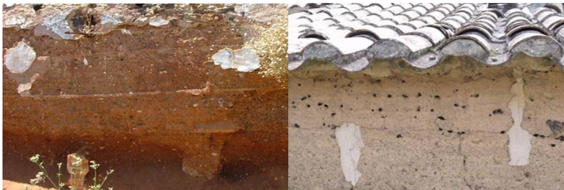
Figura 8: Erosão em parede de fachada (à esquerda) infestação por insetos (à direita)
