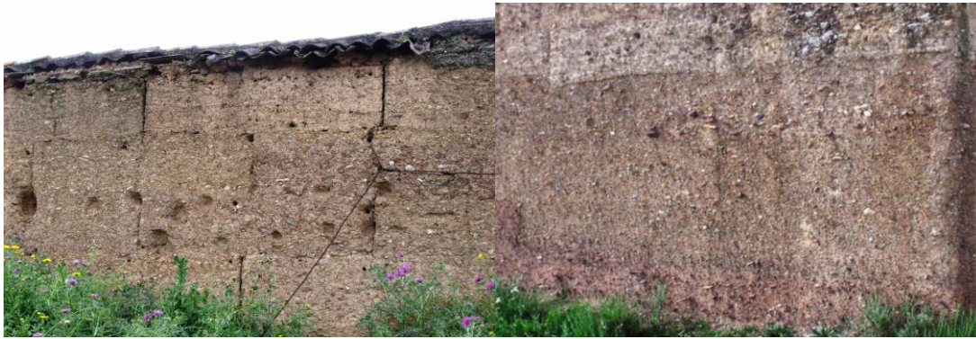
Figura 1: Aspeto de duas paredes de taipa
