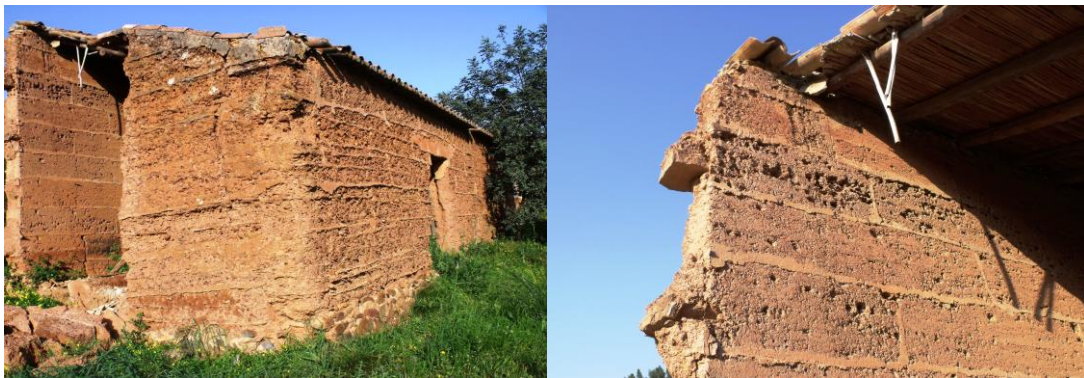
Figura 2: Paredes de taipa com juntas de terra e cal
