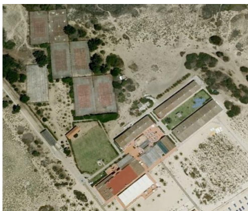
Figura 2-4: Infraestruturas da Praia do Barril
