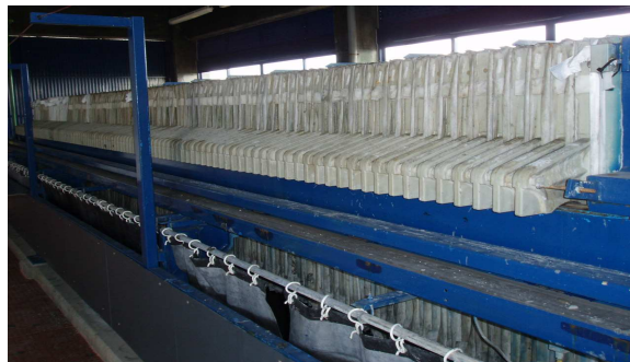
Figura 17 – Filtros prensa da ETA de Tavira.
