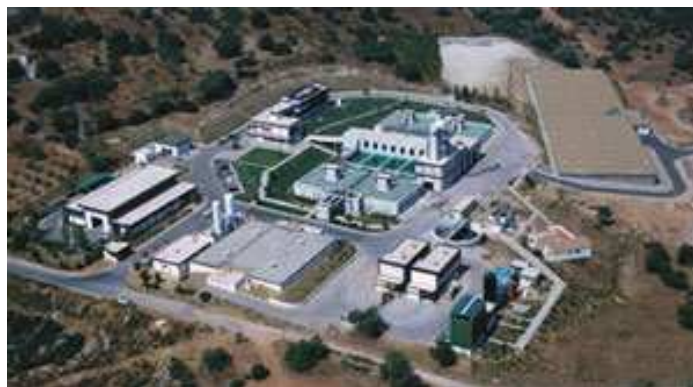
Figura 9 – Vista aérea da ETA de Tavira (fonte: Website 2).
