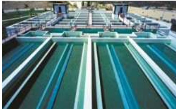
Figura 13 – Filtros rápidos de areia da ETA de Tavira (fonte: Website 2).
