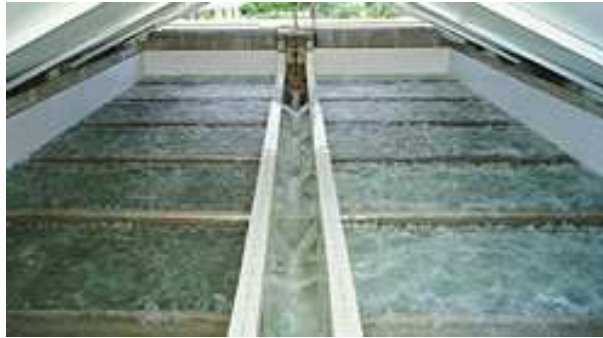
Figura 14 – Lavagem dos filtros rápidos de areia (fonte: Website 2).
