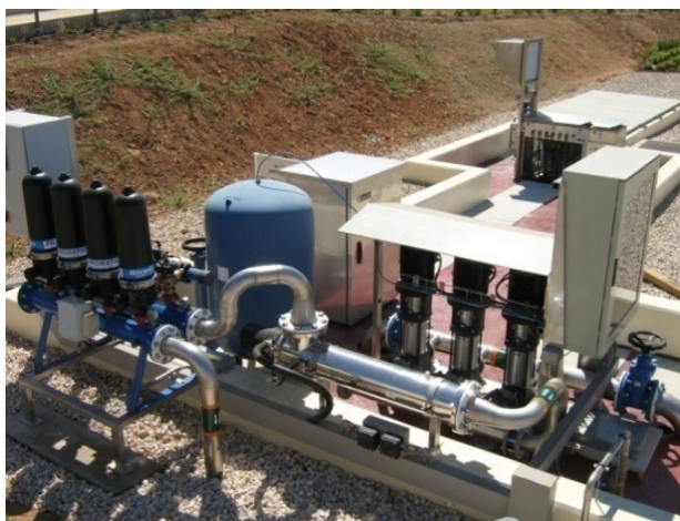
Figura 13 Sistema UV de desinfecção em linha
