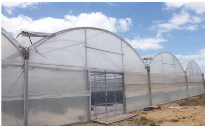
Figura 1 – Aspecto exterior da estufa metálica
