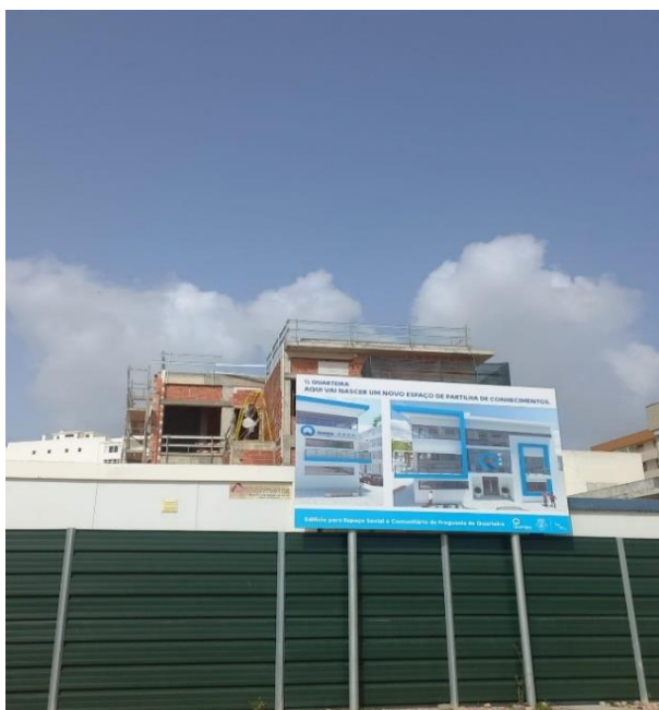
Novo edifício da Academia do Saber (em construção)
