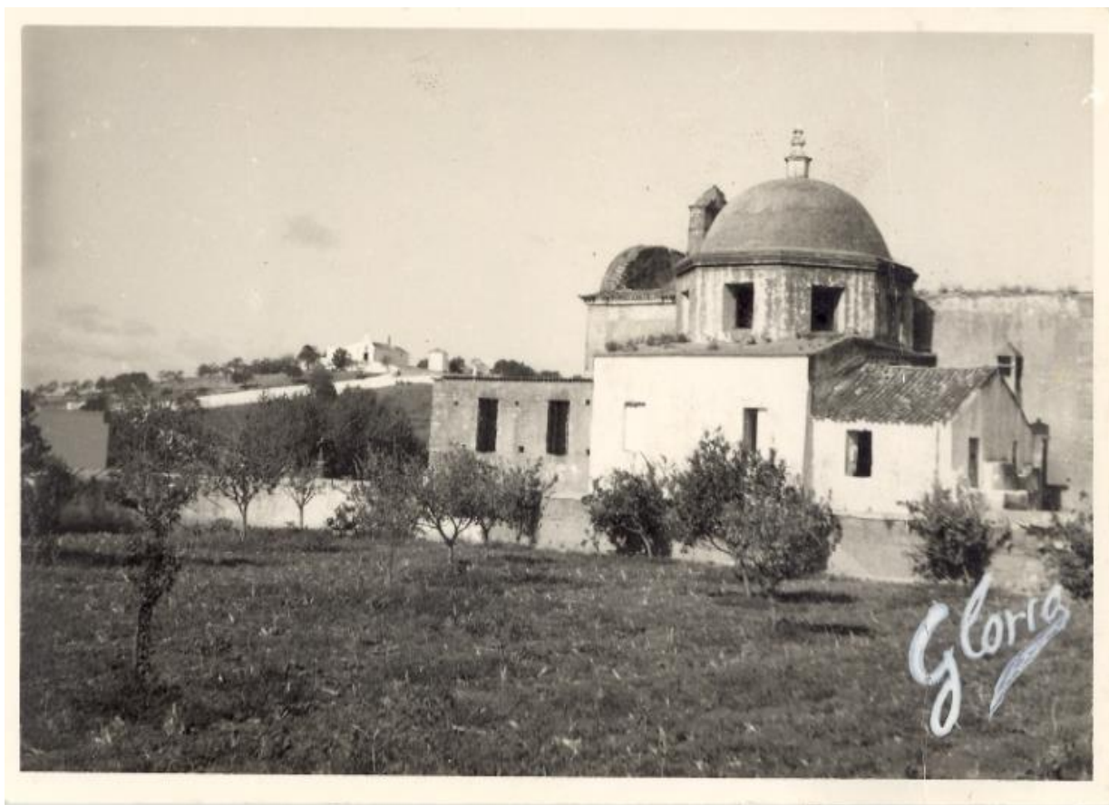
Figura 14 - Foto com tiragem provável pré-fabrica. Aqui são representadas as divisões adjacentes à Capela Lateral. Foto gentilmente disponibilizada pela CML.
