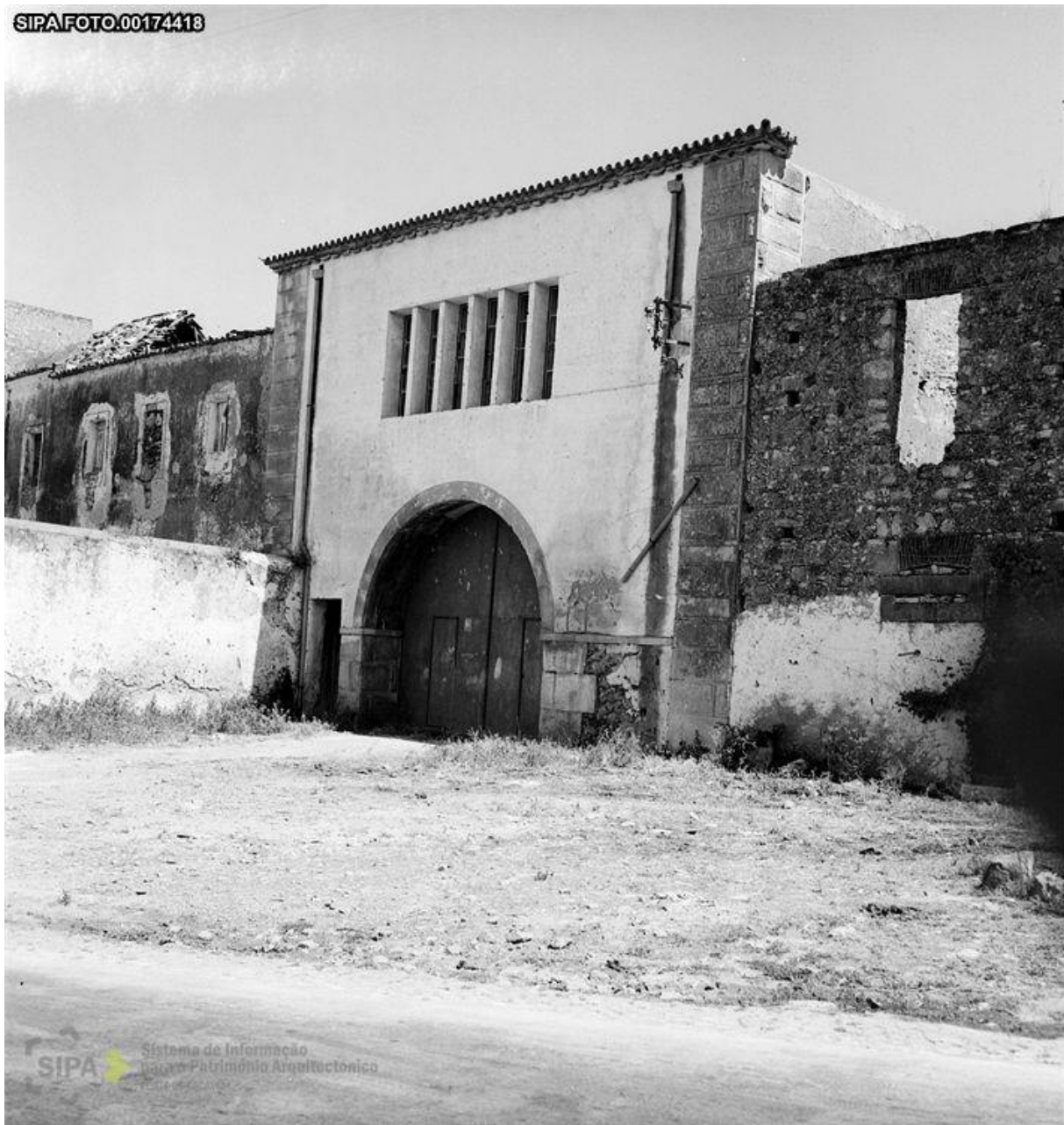
Figura 13 – Alçado Sul, 1969 – Fábrica de curtumes.
