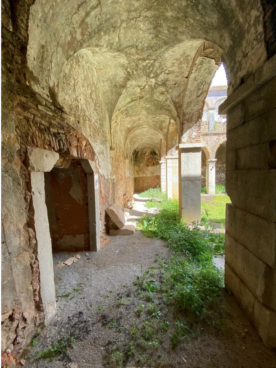
Figura 36 - Ala do Refeitório. (foto do autor)
