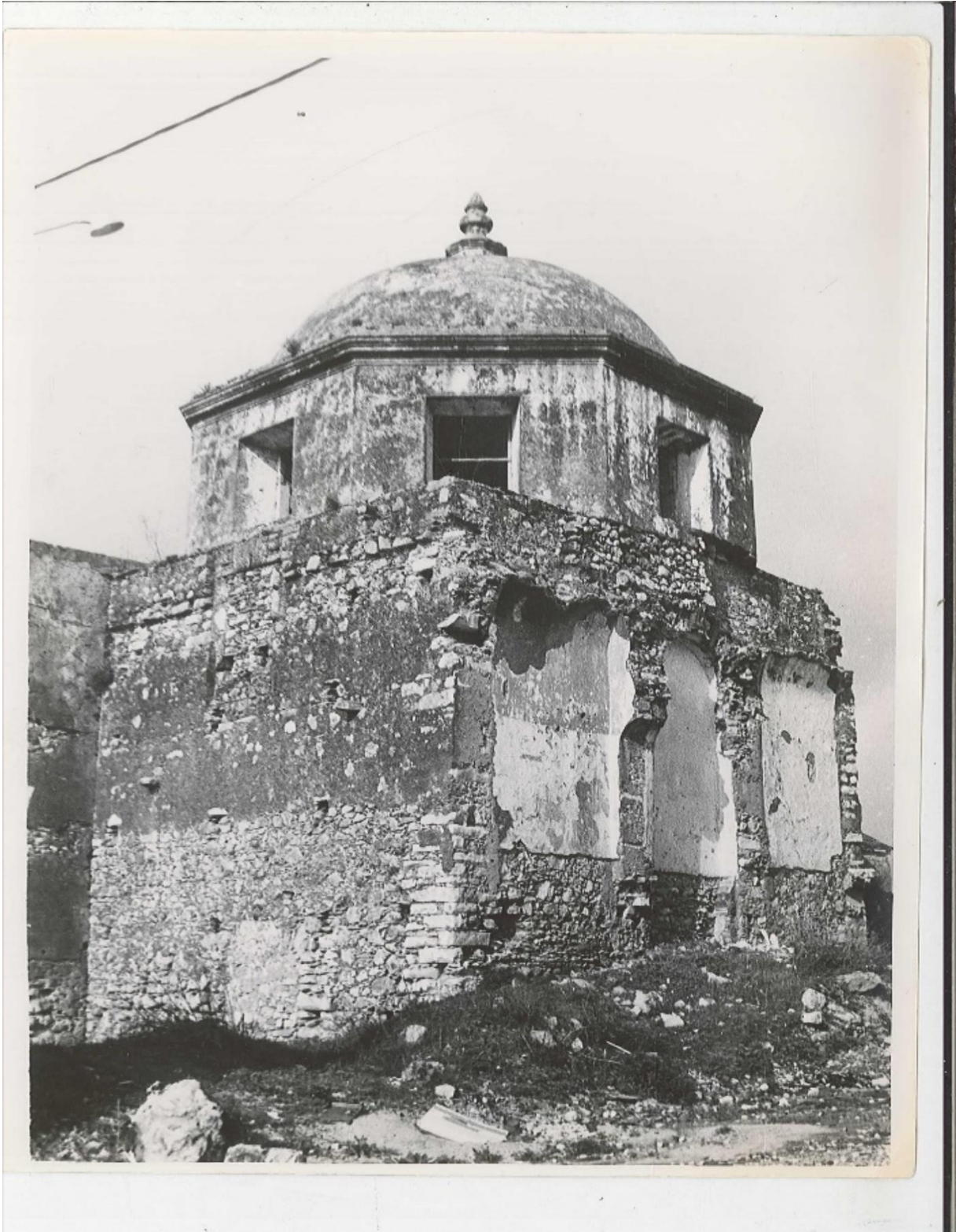
Figura 15 - Capela lateral. Note-se a cota altimétrica do solo adjacente à capela, em que comparado com os dias de hoje está bastante mais alto.
