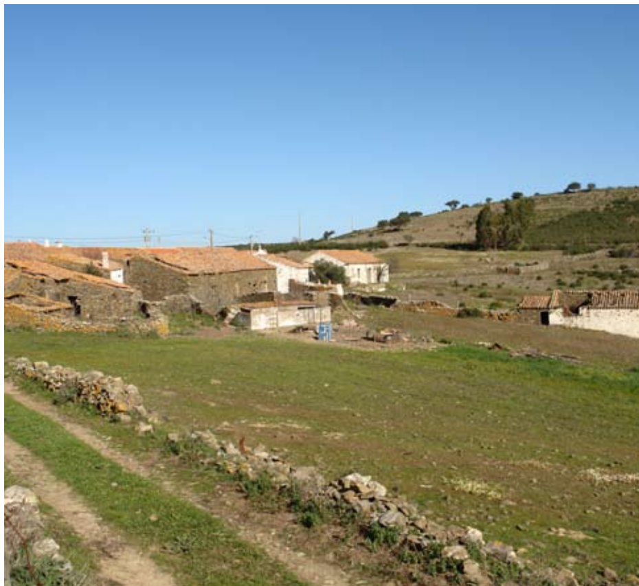
executadas, em muitos casos, com recurso a cofragem perdida de tijolo).
