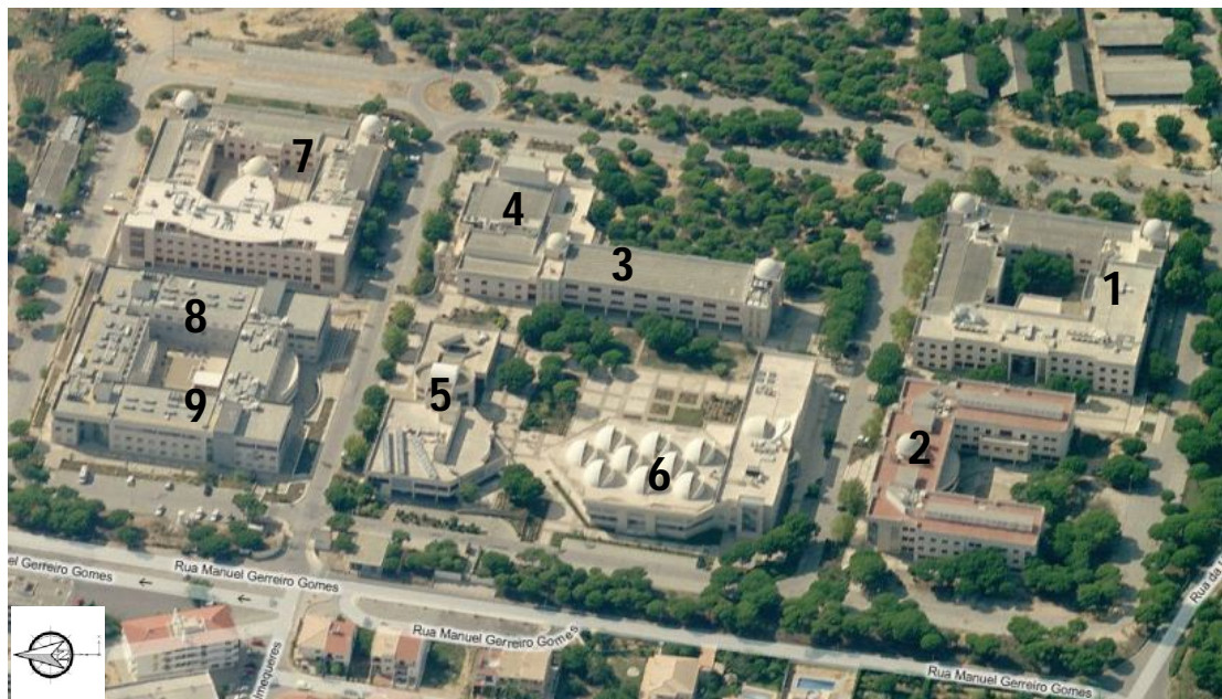
Figura 4.25 – Imagem aérea do Campus de Gambelas, com identificação dos edifícios em estudo (Fonte: http://www.bing.com/maps/ , acessado a 15/12/2012).
