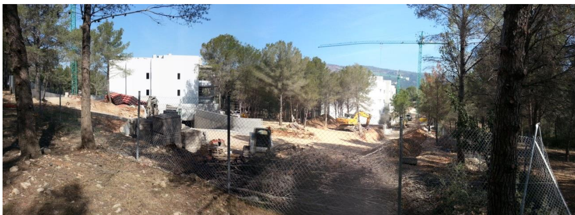
Figura 3.33 – Moradias em Construção
