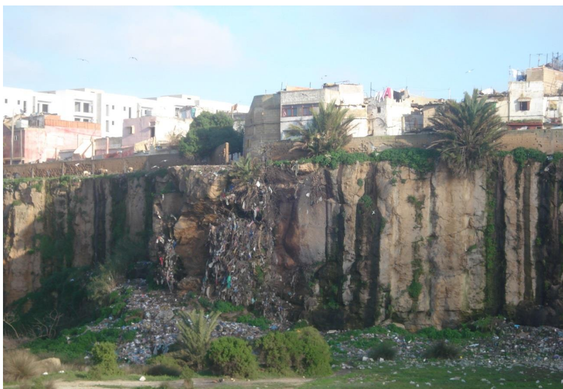
Figura 3.4 – Bairro de Lata, resíduos lançados para o espaço
