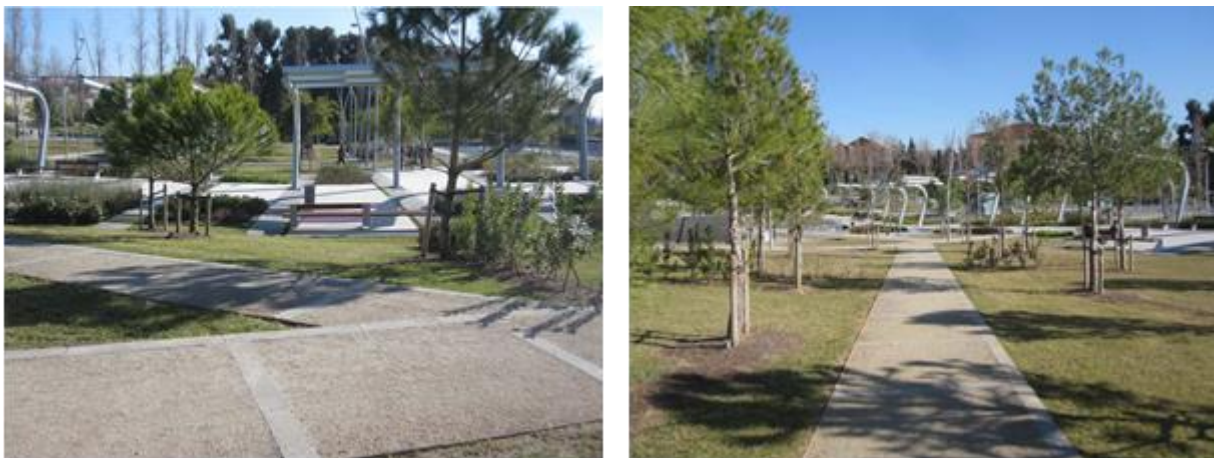
Figura 3.56 – Pavimentos estabilizados, tipo “Stabilizer”
