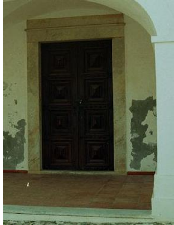
Porta da Igreja da Misericórdia em Vila Ruiva (SIPA).
