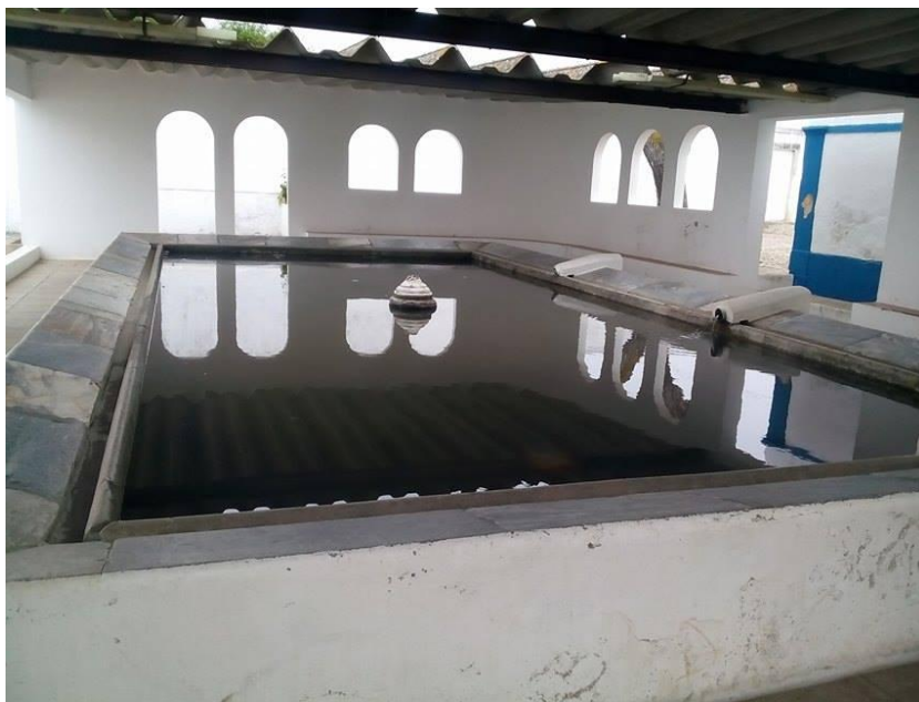
Tanque de Vila Alva: 2016.
