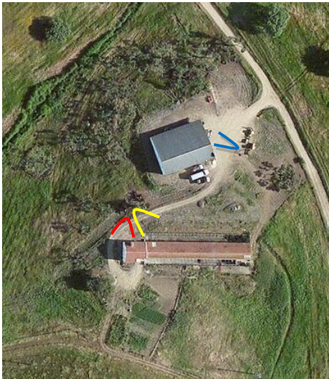
Figura 4.30- Estruturas mais recentes.
