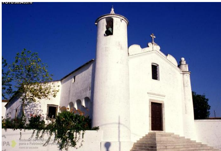
Figura 2.47- Igreja de Nossa Senhora da Visitação (SIPA).
