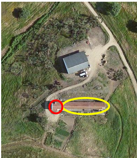
Figura 4.45- Estruturas mais recentes.
