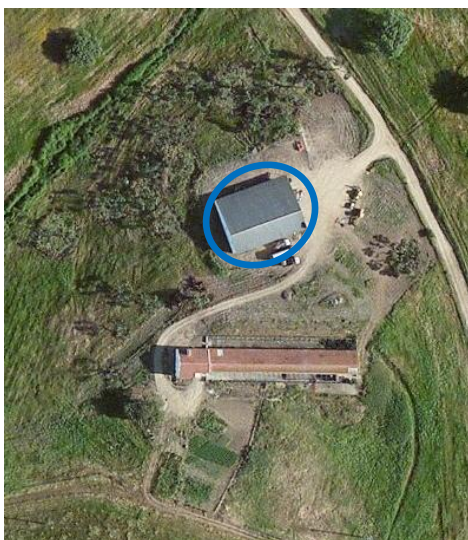
Figura 4.34- Estruturas mais recentes.
