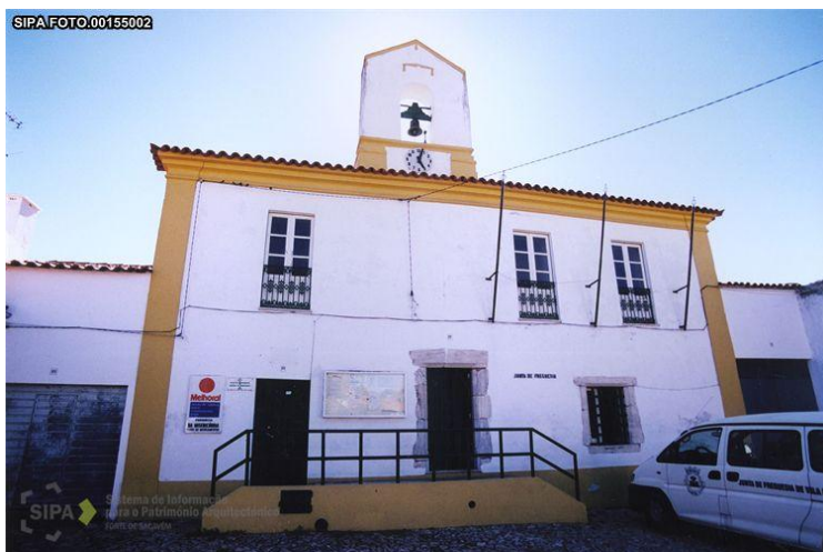
Figura 2.25- Junta de Freguesia de Vila Ruiva (SIPA).
