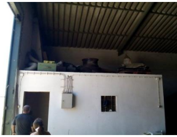
Figura 4.42- Casão grande - entrada da casa de convívio.
