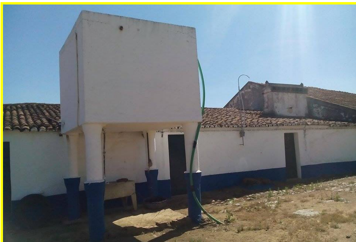
Figura 4.67 - Fachada principal do monte do Zambujal - depósito de água.
