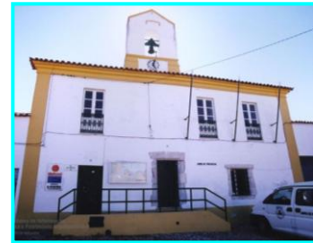
Figura 2.28- Junta de Freguesia de Vila Ruiva (SIPA).
