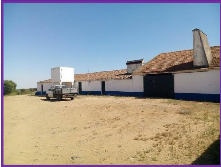
Figura 4.57- Fachada principal do monte.
