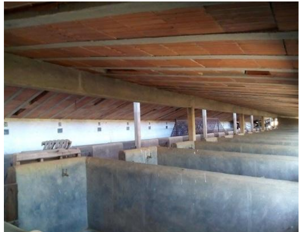
Figura 4.52- Interior da malhada - Quartelhas.
