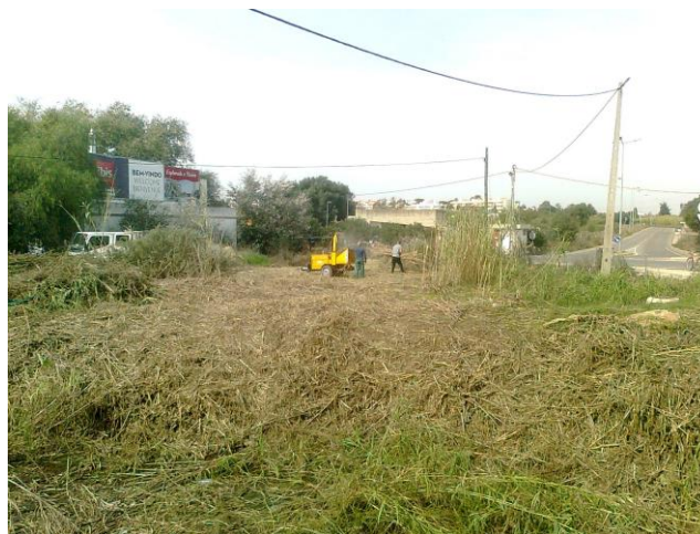
Figura 15: Equipamento de trituração com alimentação manual.
