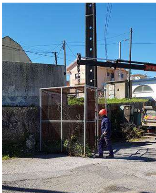
Figura 3.2 – Trabalhos de substituição de um PT em gaiola [9]
