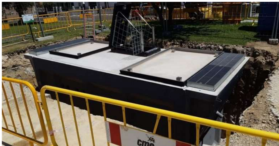
Figura 3.12 – Exemplo de PT subterrâneo pré-fabricado em fase de instalação [14]
