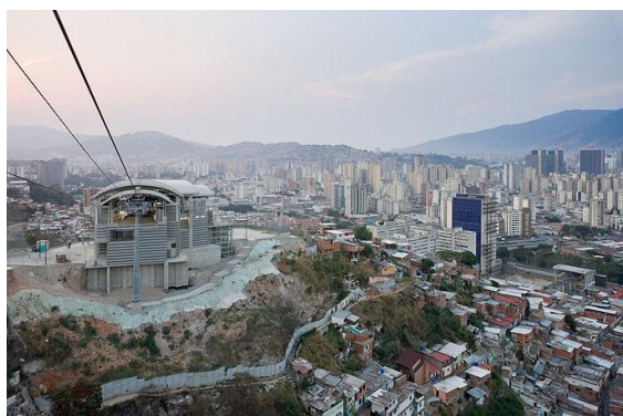
Fig. 37 – Estação do Metro-Cable em construção.
