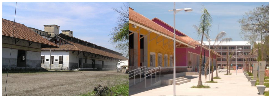
Fig.54 - Reabilitação dos edifícios antigos (“Galpões”) para criação do Centro cívico, Espaço Multiusos e Biblioteca.
