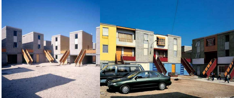
Fig. 30 - Habitação com a estrutura inicial e Fig. 31 - Habitação com ampliações após a obra. Quinta Monroe
