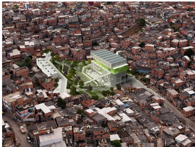
Fig. 38 – Intervenção no Grotão e zona envolvente.
