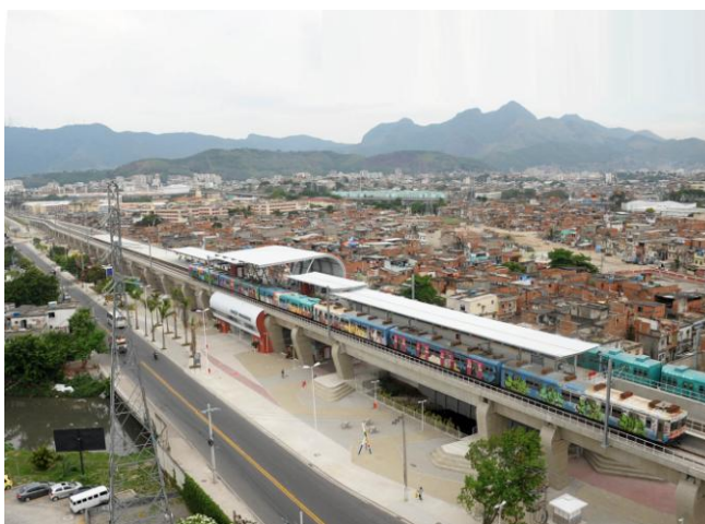
Fig.53- Estação de Mangueiras.
