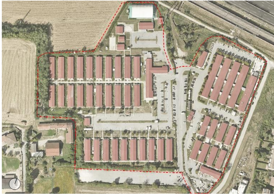
Figura 39 – Imagens satélite da localização da área de intervenção da Riqualificazione dell'area dell'ex campo base TAV (Imagens PROAP).
