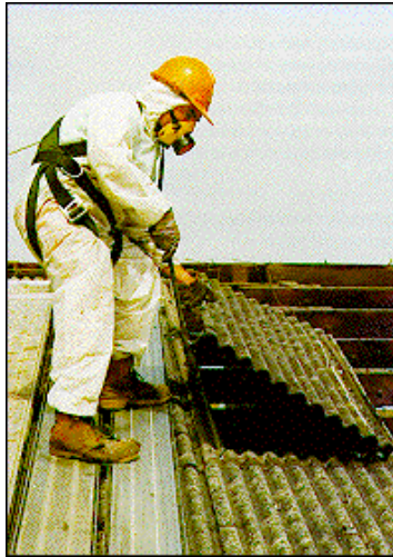
Figura 4 - remoção de telha de fibrocimento
