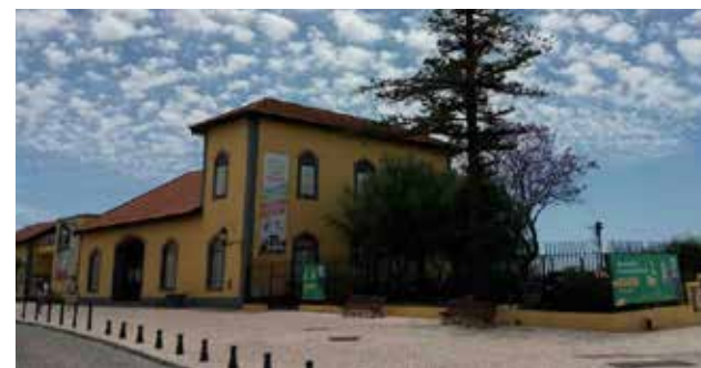
Vista do edifício do Centro Ciência Viva do Algarve
