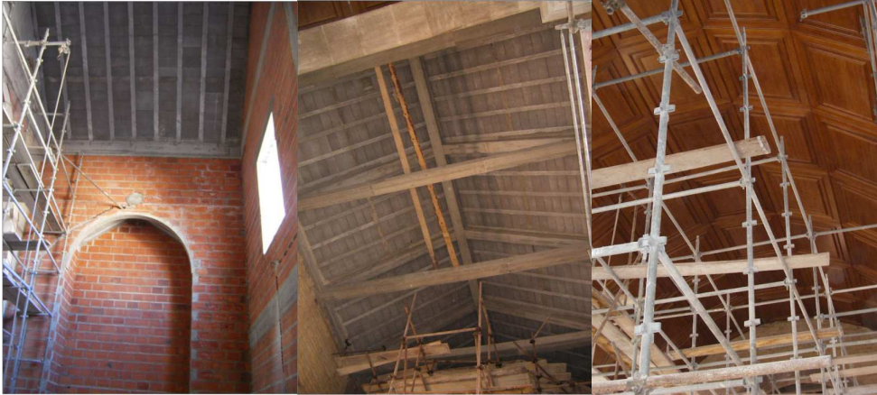
Fig. 3.16 – exemplos fotográficos* das obras da Igreja; A – nave lateral construída de raiz em tijolo cozido e cimento; B – pormenor da reconstrução do telhado em cimento; C – novo madeiramento (alóctone) passando ao domínio do visível, ocultando a ruptura construtiva empreendida.
