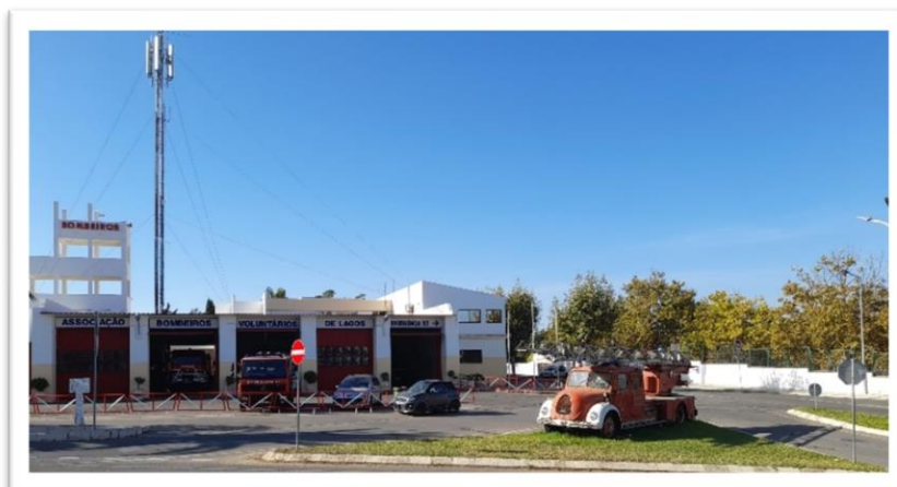
Figura 2.3 – Edifício dos Bombeiros de Lagos
