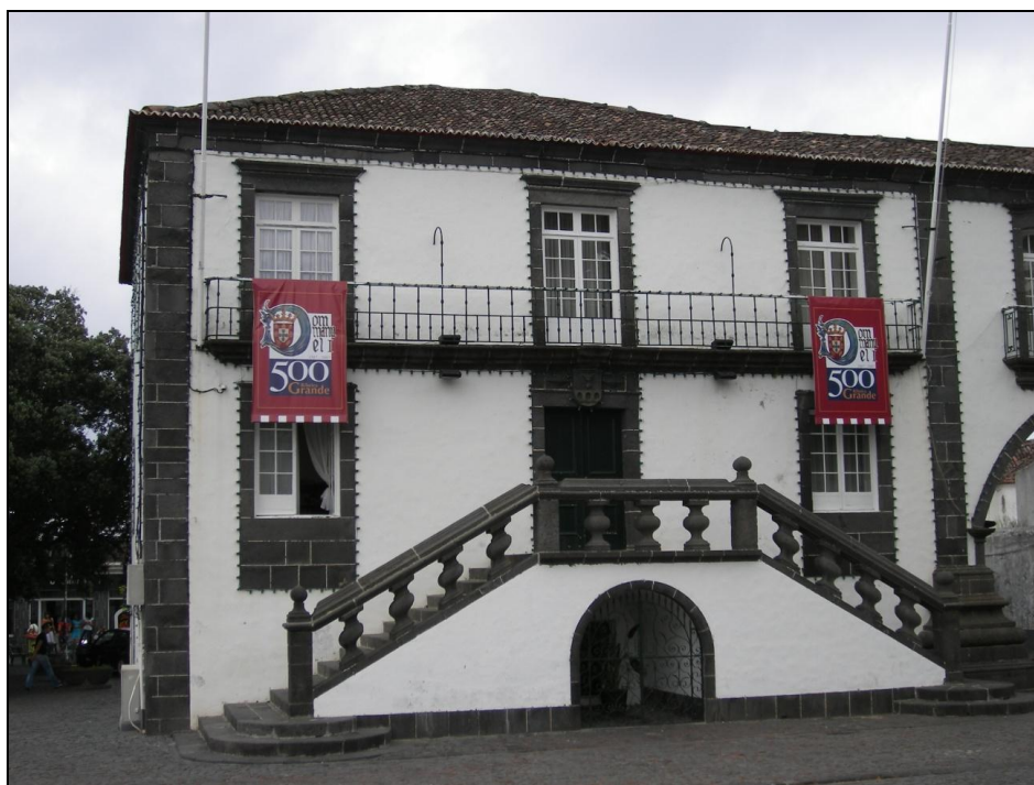
FIG. 65 – Casa de câmara e cadeia da Ribeira Grande – tramo poente do edifício, corresponde ao edifício primitivo do século XVI que depois foi acrescentado, a nascente, no século XVIII.
