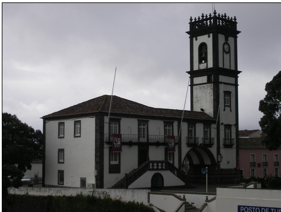
FIG. 63 - Casa de câmara e cadeia da Ribeira Grande – perspectiva da fachada principal e da torre
