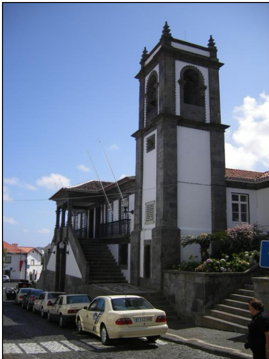
FIG. 17 – Casa de câmara e cadeia da Praia da Vitória – perspectiva da torre e fachada. Foto: Mateus Eduardo da Rocha Laranjeira
