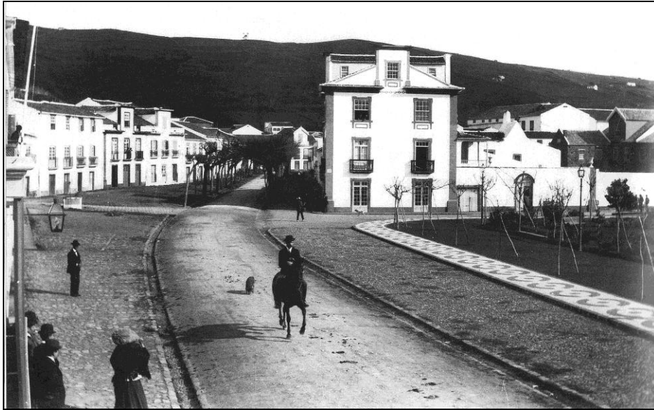
FIG. 102 – Fotografia panorâmica da antiga praça, da segunda metade do século XIX, de novo na perspectiva de sul para norte. Do lado esquerdo da imagem ainda é perceptível o lajeamento de basalto escuro que antecedia a casa de câmara. Após a demolição do convento da Glória (que se situaria à direita da imagem), o mesmo foi transformado em jardim público, a então praça D. Carlos I, posterior praça da República, como é perceptível no lado direito da foto.
