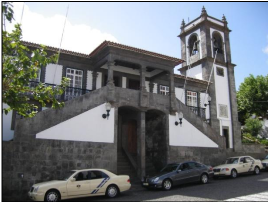
FIG. 163 – Casa da câmara da Praia da Vitória.
