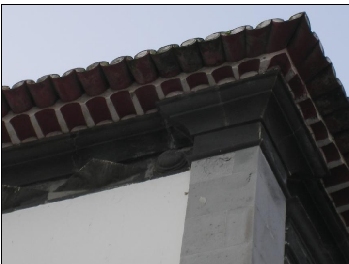
FIG. 51 – Cunhal do alçado sul com a fachada principal – pormenor das “pontas de diamante” e da roseta presentes na cornija.
