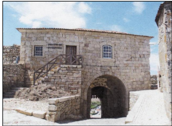
FIG. 160 – Casa da câmara de Penamacor.
