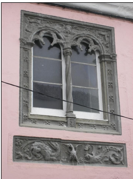
FIG. 70 – Janela manuelina existente no edifício a nascente da casa de câmara e cadeia da Ribeira Grande.
