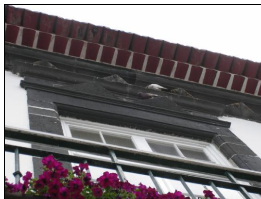
FIG. 46 – Pormenor das “pontas de diamante” presentes no lintel da janela de sacada e na cornija do edifício.
