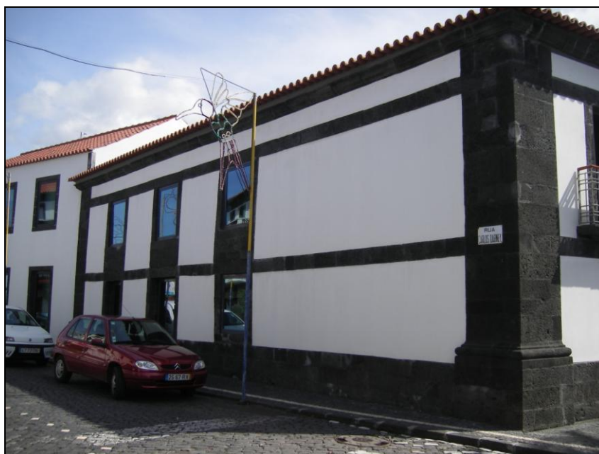
FIG. 114 – Casa de câmara e cadeia da Madalena do Pico – perspectiva do alçado lateral norte.
