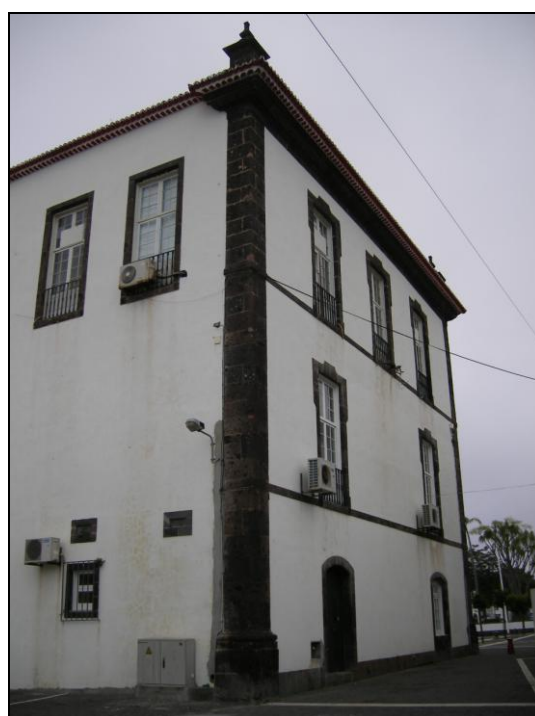
FIG. 31 – Casa de câmara e cadeia de Vila Franca do Campo – perspectiva do cunhal dos alçados lateral norte e posterior do edifício.
