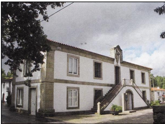
FIG. 165 – Casa da câmara de Cabeceiras de Basto.
