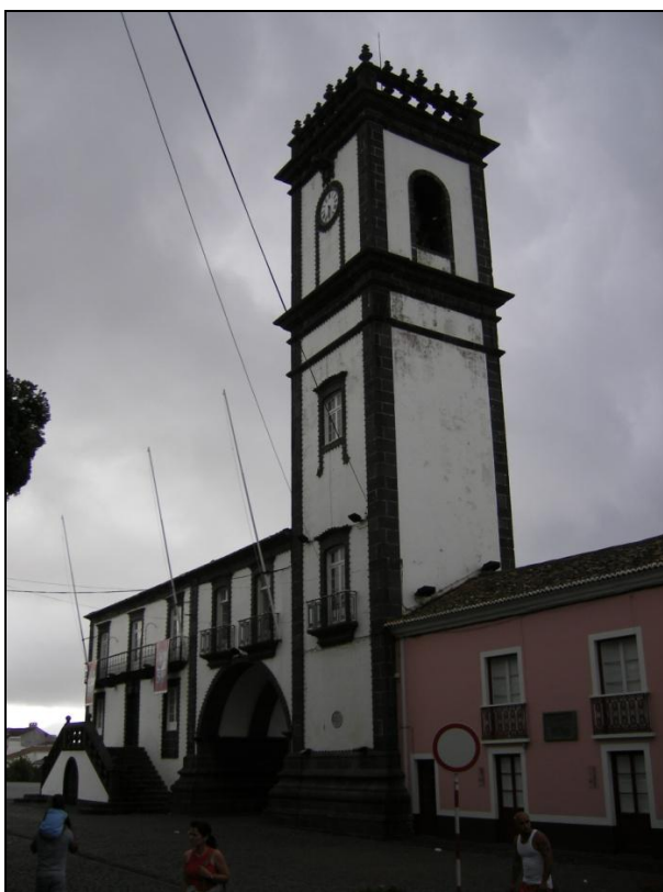
FIG. 68 – Fachada principal – perspectiva da torre.
