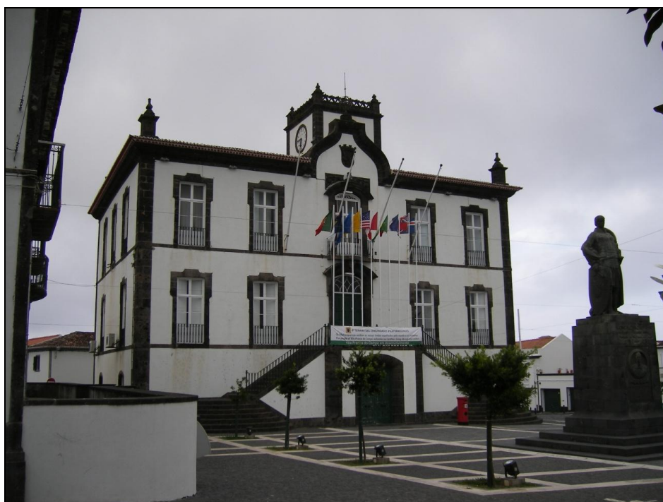
FIG. 27 – Casa de câmara e cadeia de Vila Franca do Campo – fachada principal.
