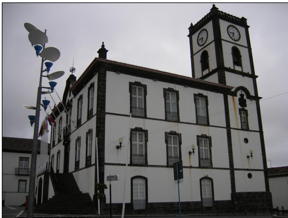
FIG. 29 – Casa de câmara e cadeia de Vila Franca do Campo – perspectiva do alçado lateral sul, em cujo cunhal sudeste se encontra, adossada, a torre.
