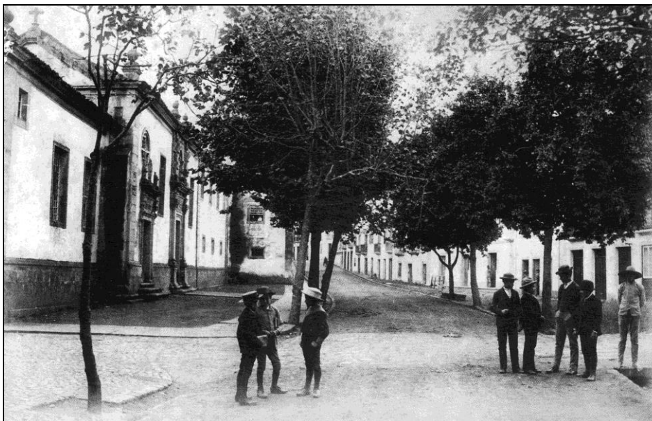
FIG. 101 – Fotografia panorâmica da praça, de meados do século XIX, captada de norte para sul. À esquerda vê-se o famigerado convento da Glória, entretanto convertido em passeio público. À direita, após o último edifício captado, situava-se a casa de câmara e cadeia da Horta. Já nesta altura, anterior à demolição do convento da Glória, já a praça tinha sido convertida em alameda, onde as árvores delimitavam a rua, quebrando, deste modo, a vivência de praça/largo que tinha originalmente.
