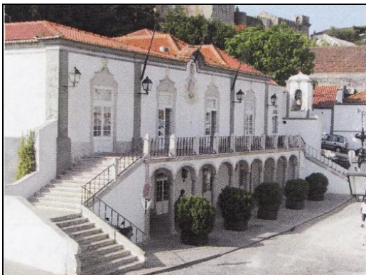
FIG. 179 – Casa da câmara de Palmela.
