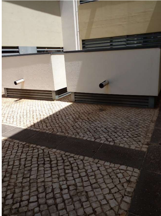
Figura 4.7 - Imagens das Floeiras sobrelevadas do pátio em U (Pátio das Oliveiras), em 2021 (foto da autora).
