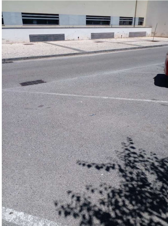
Figura 4.6 - Imagem do parapeito exterior, paralelo ao pátio em U, em 2021 (foto da autora).
