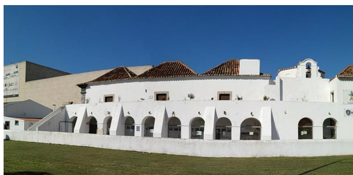
Figura 21 - A tardez da casa nobre, encontrava-se a escadaria que fazia ligação à varanda da casa. (Fonte: autora)
