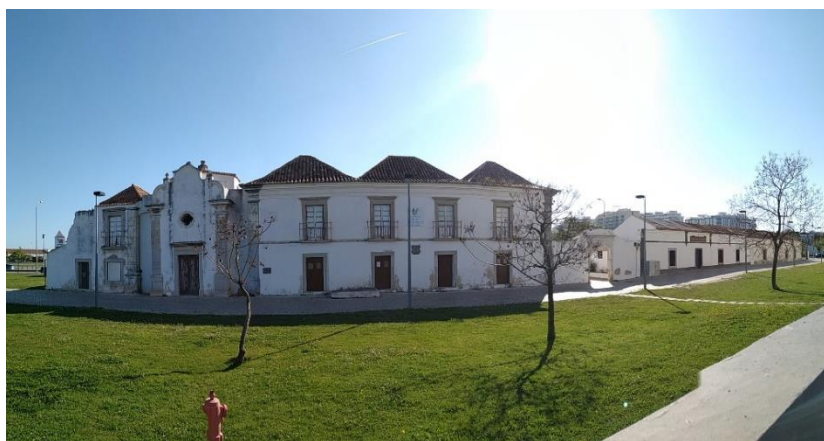
Figura 20 - Edifício 1: casa nobre, capela e casa dos caseiros. (Fonte: autora)
