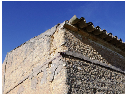
Figura 5. Colocação de tirante
