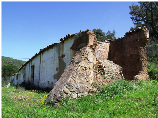
Figura 4. Existência de contraforte
