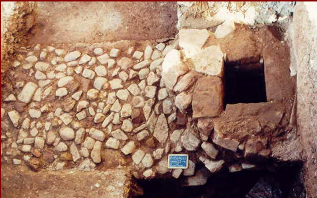
Bocal de acesso à galeria
