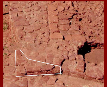
Reforço do cunhal
