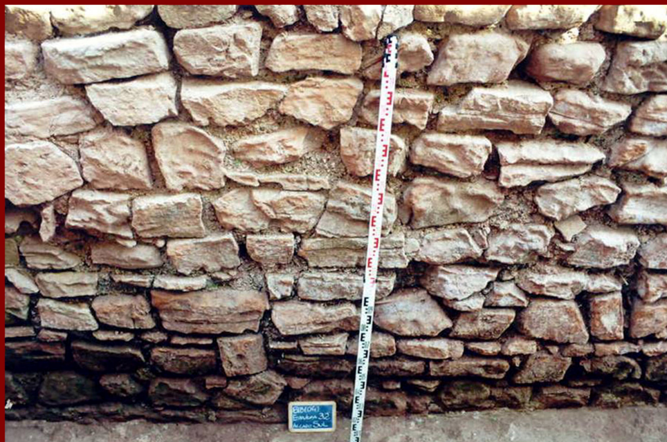
Parte do alçado sul da Estrutura 32
