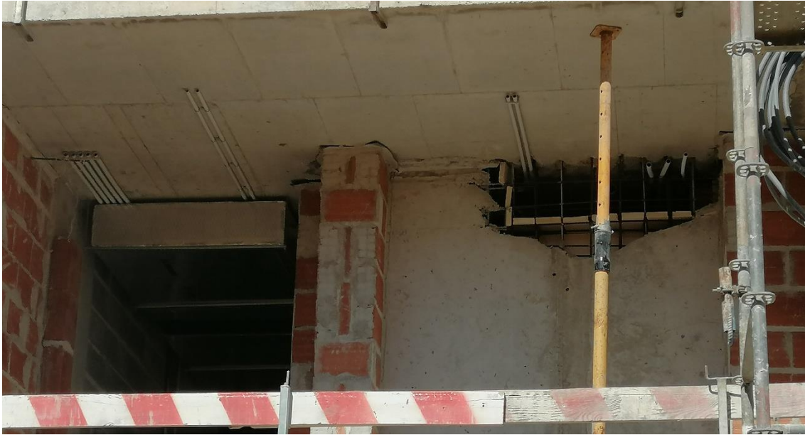
Figura 0.7 - Negativo para prumadas de AVAC
