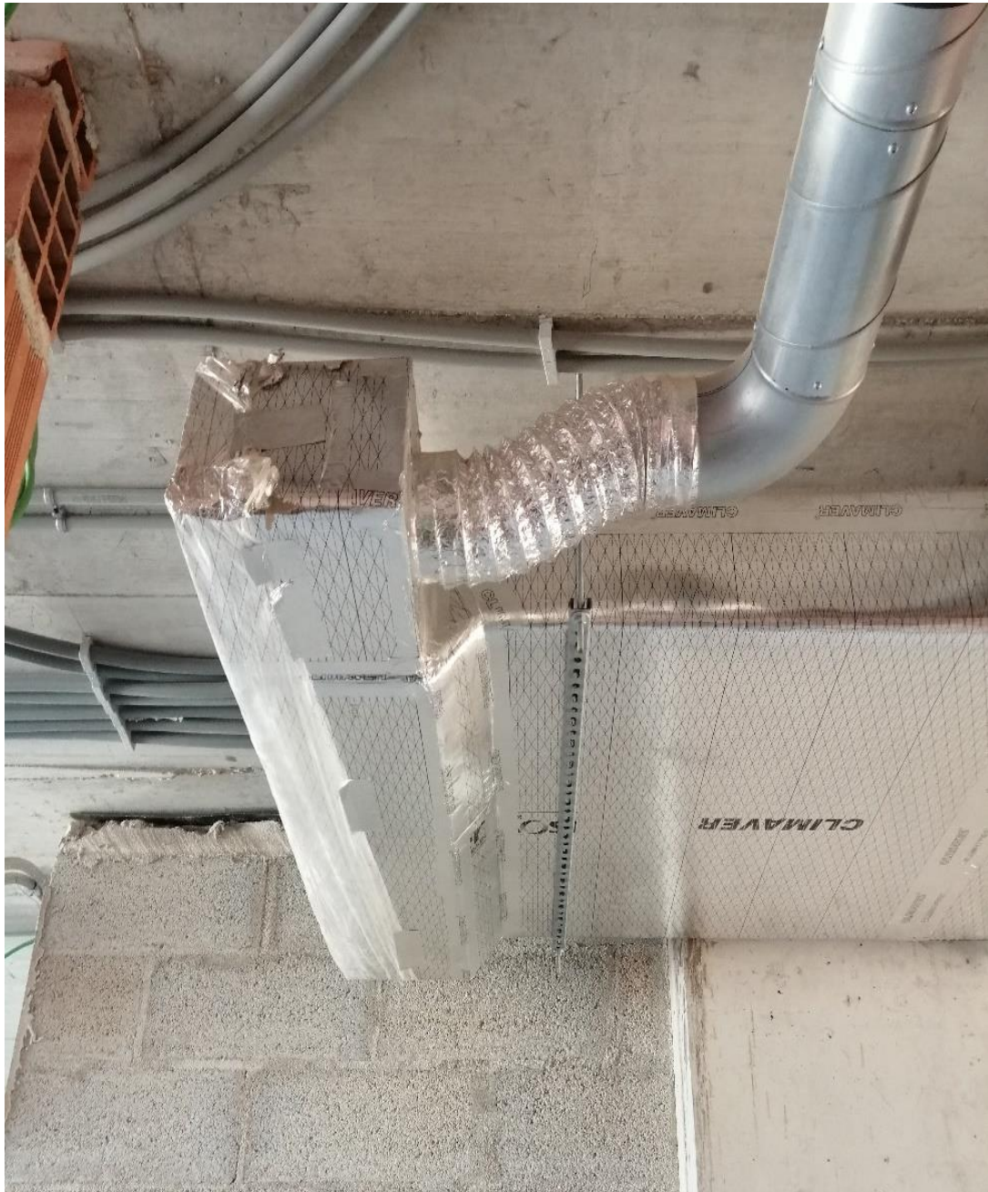
Figura 0.5 - Conduca spiro e climaver – Ar novo
