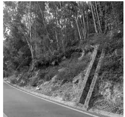
Figura 5 Um dos vários aquedutos de drenagem das águas pluviais
