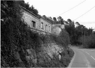
Figura 2 Muro do copo de água
