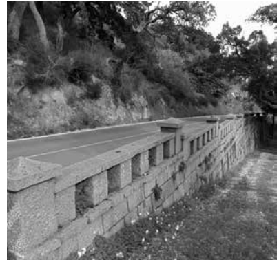
Figura 4 Muro de suporte e respectivo acabamento ao gosto da época
