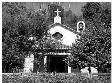
Figura 1, 2 e 3 Exemplos de edifícios de função com interesse arquitectónico nas Caldas de Monchique: o antigo balneário provisório, o Chalet Mascarenhas e a Capela de Santa Teresa e S. João de Deus.
