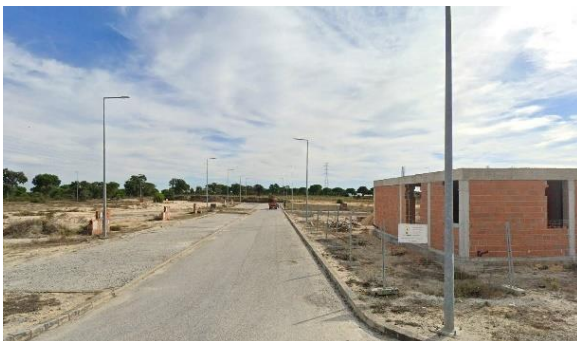
Figura 17 - Habitação e loteamentos em construção | Fonte: Do autor
