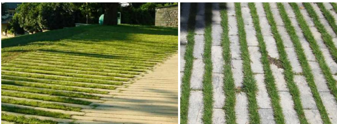
Figura 84 - Pavimento com junta aberta em pedras - estereotomia fina, com marcações lineares – Proap
