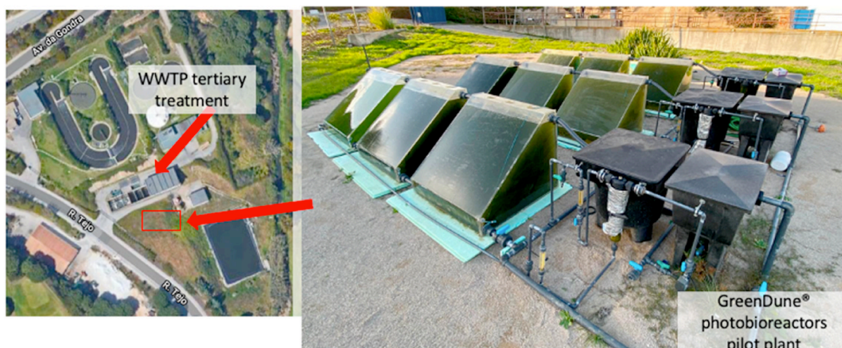
Figura 6. Fotobiorreatores GreenDune instalados na estação de tratamento de águas residuais da Quinta do Lago (Algarve, Portugal) (Morais et al., 2022).
