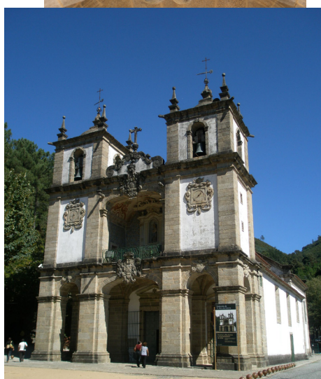
Bouro. Santuário de Nossa Senhora da Abadia. Fachada principal com o seu retábulo.
