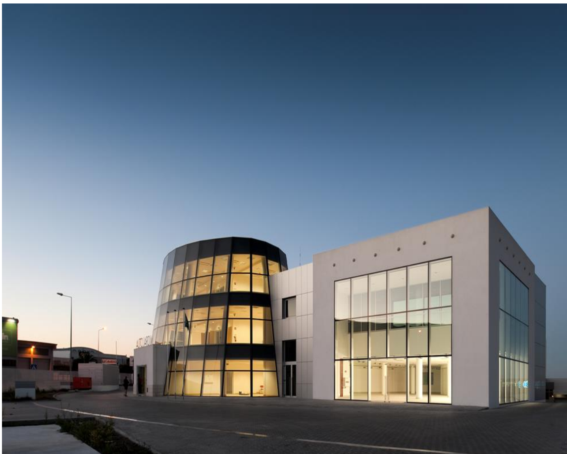
Figura 12 – Edifício com iluminação ligada
