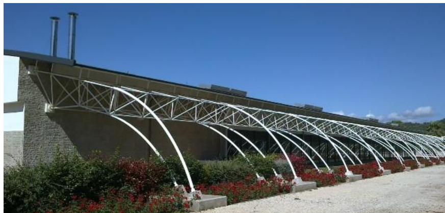
Figura 53 – Fachada orientada para sudoeste com pala de sombreamento e maior área de vãos transparentes (C).
