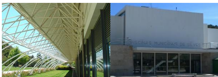
Figura 61 – Palas de sombreamento horizontais, à esquerda a fachada SO e à direita a NE.
