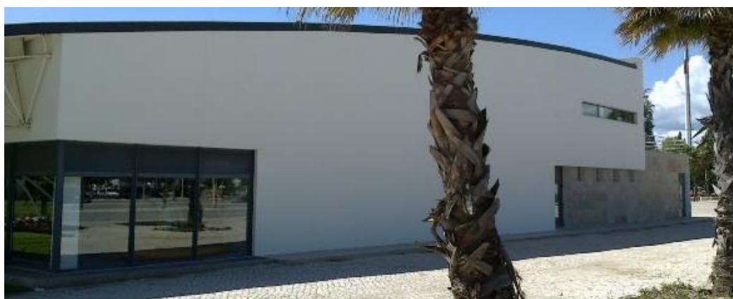
Figura 52 – Fachada lateral orientada para sudeste (B).
