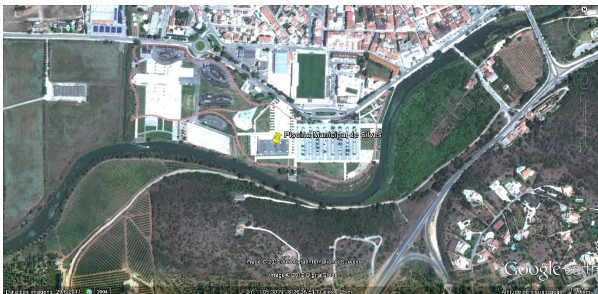
Figura 48 – Localização da piscina municipal de Silves, Google Earth em 01 de agosto de 2012.
