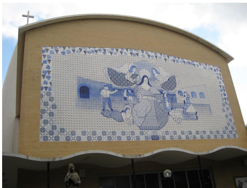
Figura 2.27 - fachada da igreja com o painel da pintora Djanira. Mello (2014).
