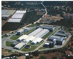
Figura 2 – ETA de Alcantarilha coberta (AdA, 2007c)
