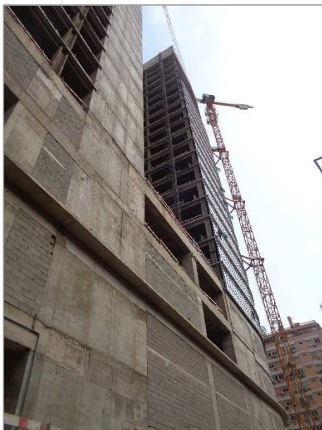
Fotografia 1 – Vista Lateral – Torre 2 e 3
