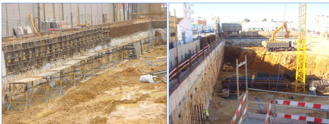
Figura 51 - Escavação Edifício Ondas do Mar
