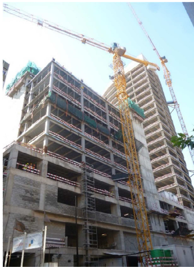
Figura 13 - Vista Geral Embasamento
