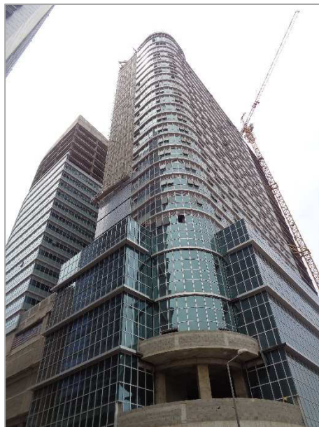
Fotografia 6 – Vista Torre 1 - NE
