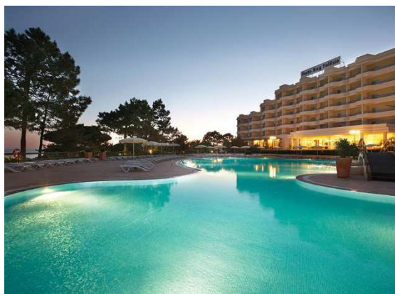
Figura 46 - Hotel Porto Bay - Vista Exterior
