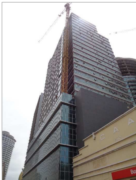
Fotografia 5 – Vista Torre 1 - SE
