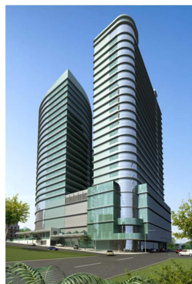
Figura 10 - Vista ESTE Luanda Towers
