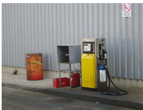
Figura 8 - Posto de Combustível
