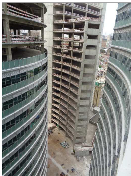
Fotografia 4 – Vista – Torre 1, 2 e 3
