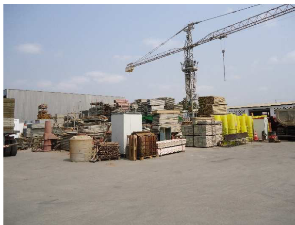
Figura 7 - Estaleiro de Viana - Zonas Exteriores
