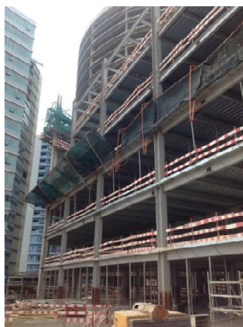
Figura 15 - Vista Geral Estrutura - Piso 7
