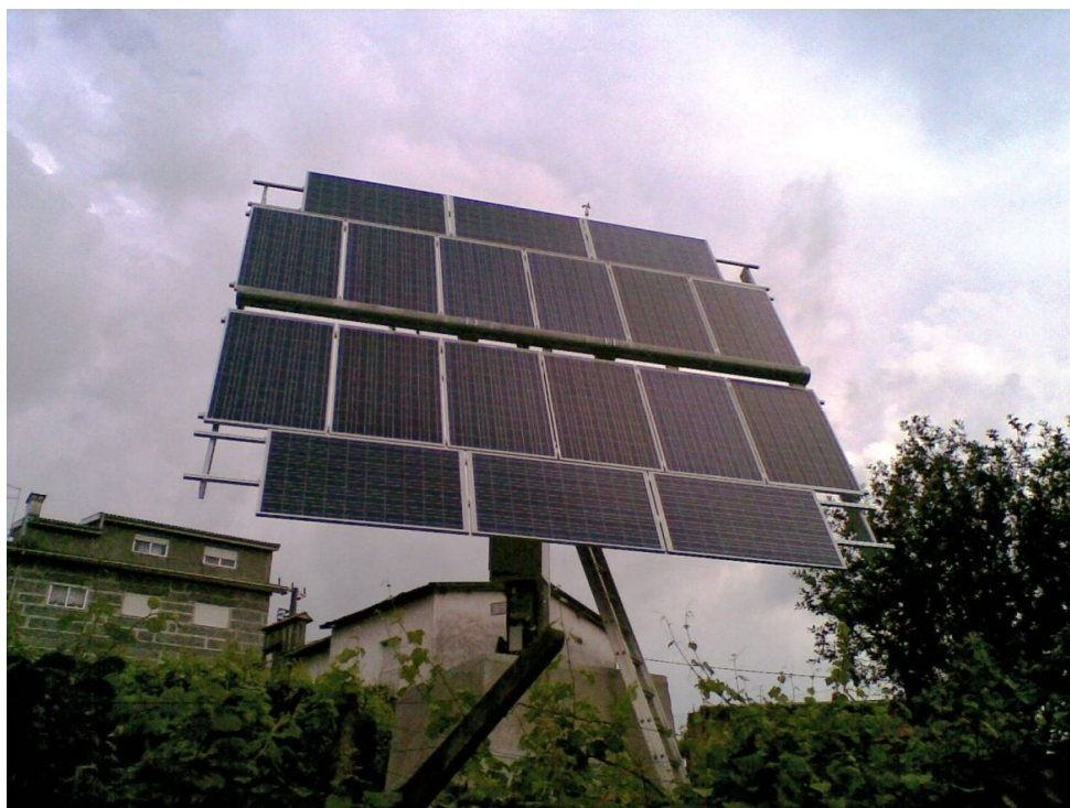
Seguidor de 2 eixos em Barcelos
