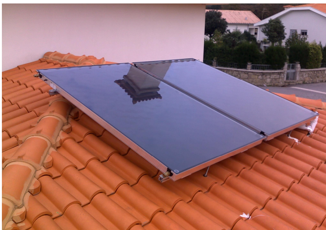
Instalação de Sistema de Circulação Forçada 300L em Barcelos
