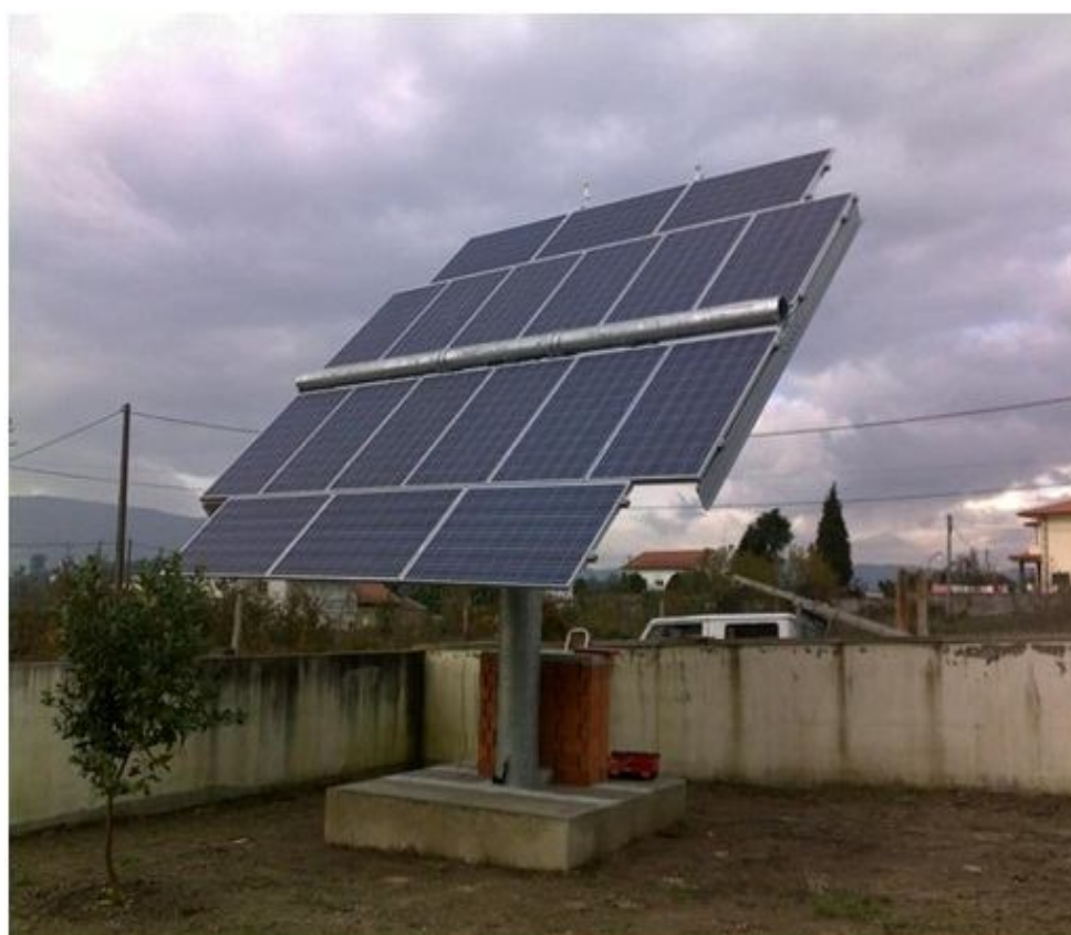
Seguidor de 2 eixos em Barcelos
