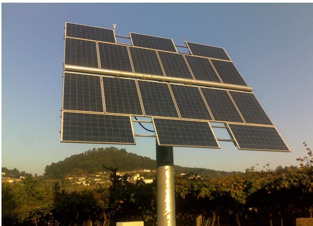
Seguidor de 2 eixos em Barcelos
