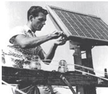
Figura 12 – A primeira aplicação de uma célula solar de silício foi como fonte de alimentação de uma rede telefónica local em Americus, na Geórgia, Estados Unidos da América, em 1955, (extraído da referência [3]).
