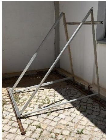
Figura 29 - Estrutura suporte para montagem do painel fotovoltaico
