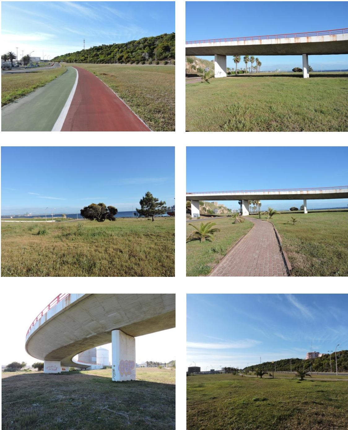
Figura 4.3 – Imagens da área de estudo, antes da intervenção (fotos da autora, 2005).
