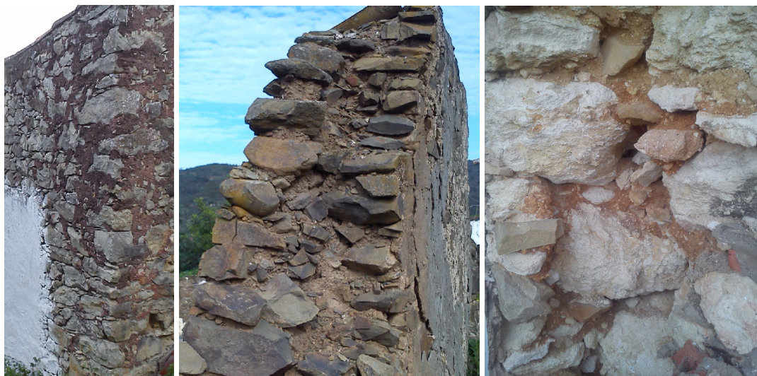
Figura 1: Exemplos de paredes de alvenaria de edifícios existentes no Algarve.
