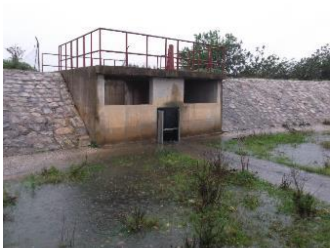
Figura 5 – Dique e descarregadores.
