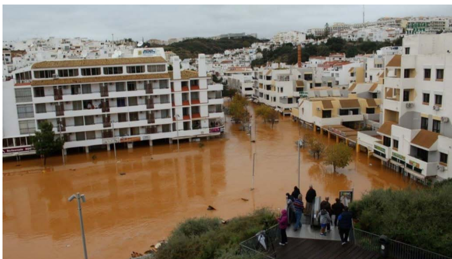
Figura 7: Inundação da Praça dos Pescadores a 01/11/2015, Albufeira.
