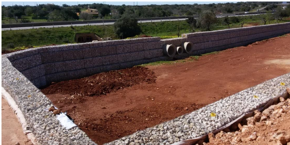
Figura 123 – Aspeto geral da bacia de retenção 1 com a cota de soleira ainda por atingir. Vista de Nascente.
