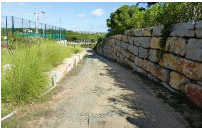
Figura 18: Caminho de circulação pedonal e automóvel e respetiva margem ajardinada, sobrejacentes a uma bacia de retenção enterrada – Almancil, Faro.
