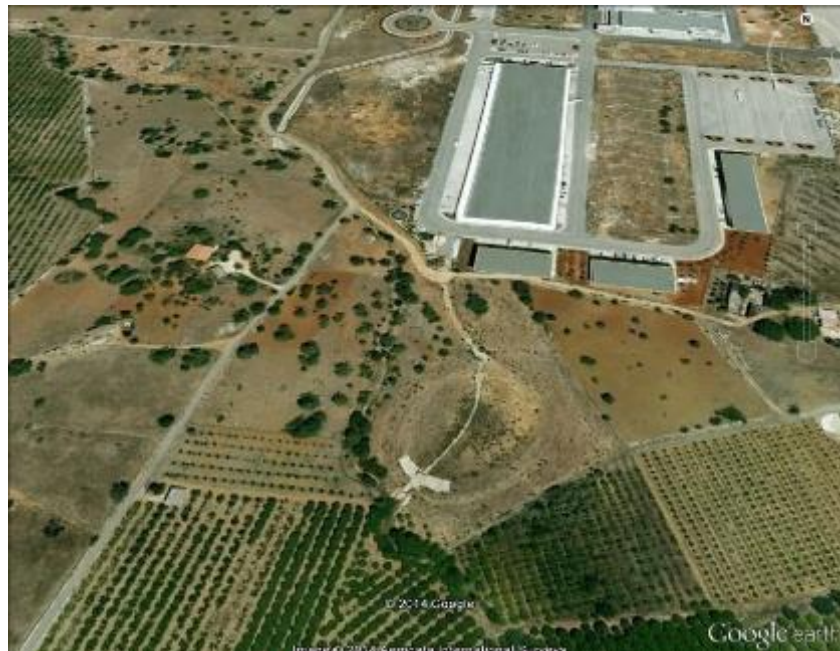
Figura 2 – Vista aérea da bacia de retenção.
