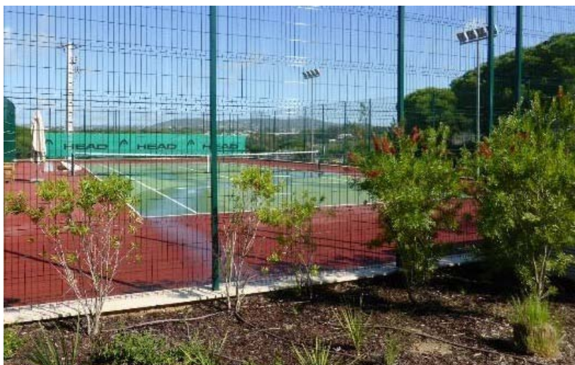
Figura 17: Campo desportivo sobrejacente a uma bacia de retenção enterrada – Almancil, Faro.
