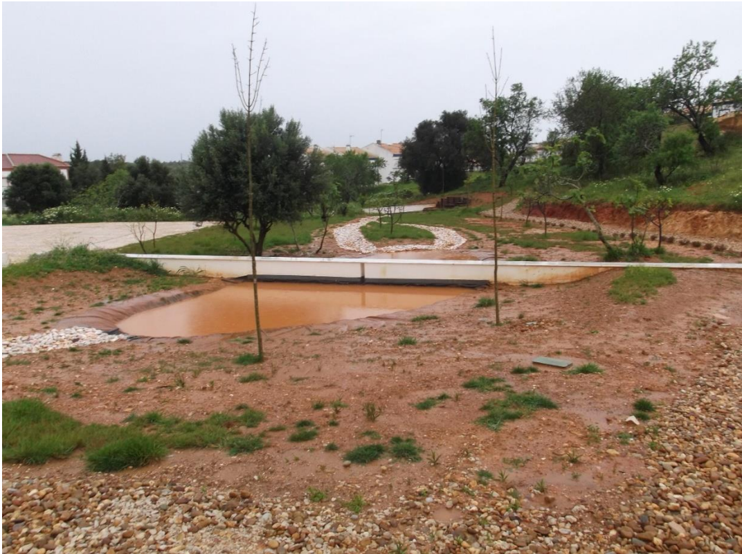
Figura 49 – Vista de montante do conjunto de bacias de retenção.
