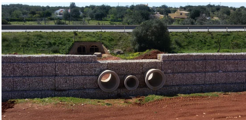
Figura 121 – Descarregadores de fundo, meio fundo e superfície da bacia de retenção 1.
