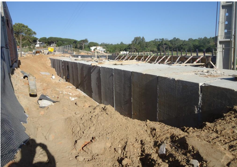
Figura 85 – Fase de construção da bacia de retenção Norte, após ligação de todos os box-culvert.
