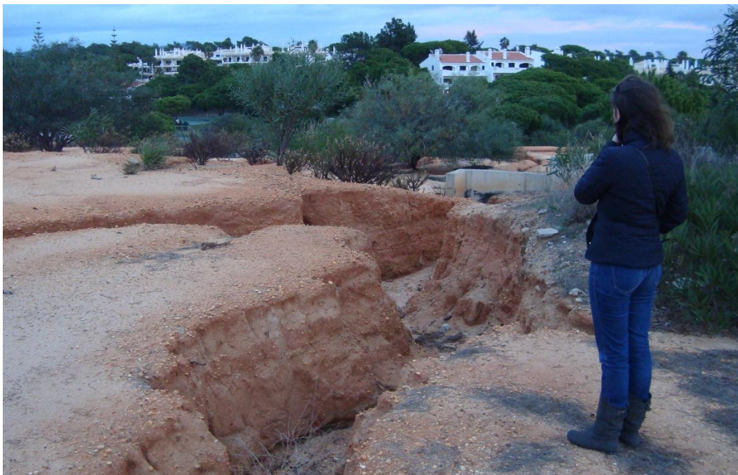
Figura 69 – Ravinamento observável na área do loteamento.
