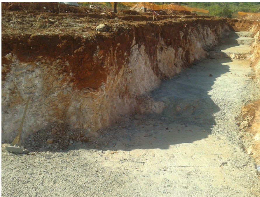
Figura 117 – Escavação e aplicação de betão de limpeza para colocação de gabiões.
