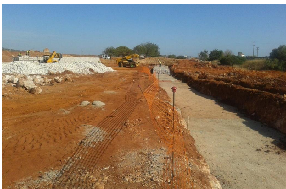
Figura 118 – Início da colocação de gabiões.
