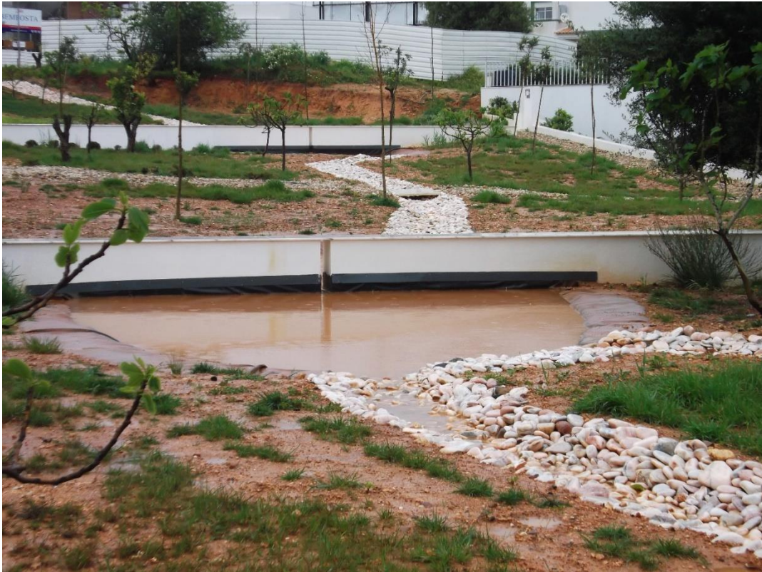
Figura 51 – Vista de jusante da bacia de retenção intermédia.
