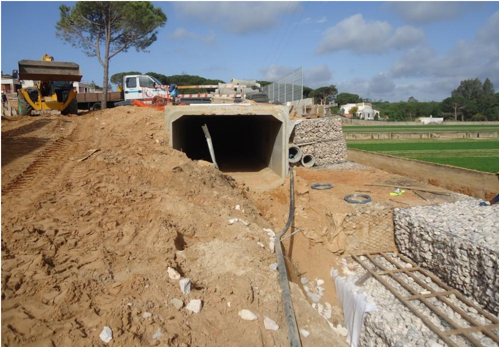
Figura 84 – Fase de construção da bacia de retenção Norte e da vala de dissipação.
