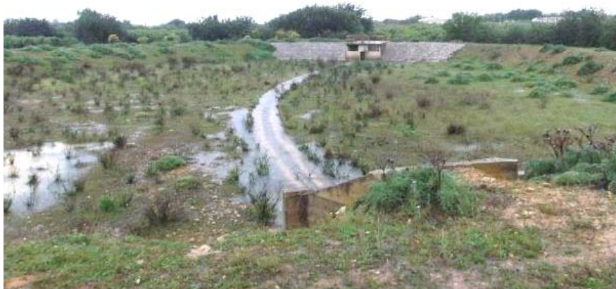
Figura 20: Bacia de retenção com canal revestido para escoamento de pequenos caudais (Faro).
