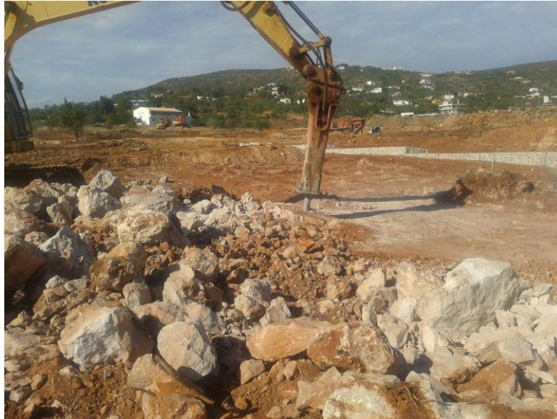
Figura 119 – Trabalho de escavação no interior da bacia de retenção 1 para estabelecimento da cota de soleira.
