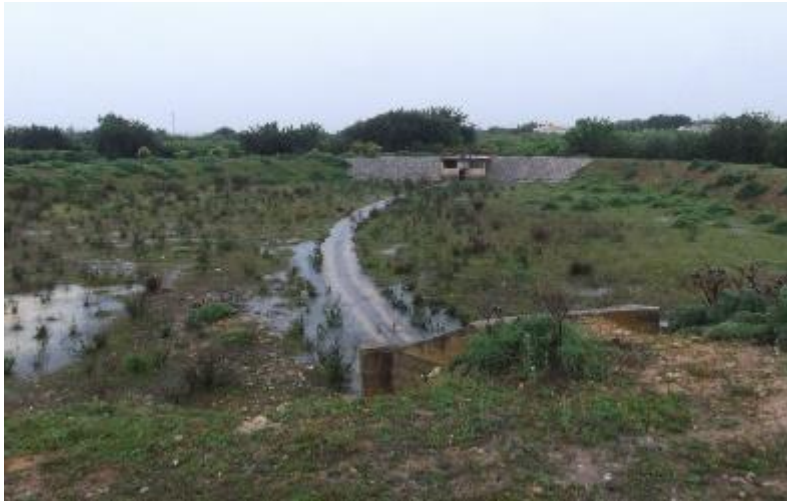
Figura 3 – Aspeto geral da bacia de retenção (vista para jusante).
