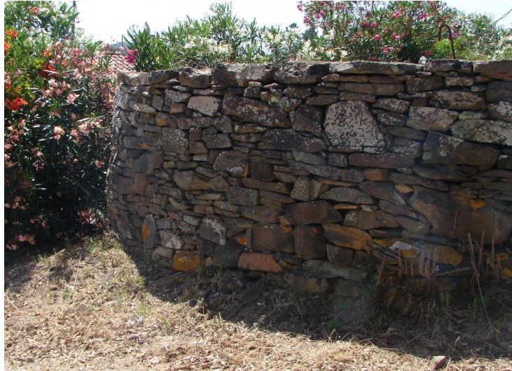
Figura 3.27. Muro com aparelhamento poligonal, Malhão, Serra do Mu. Fonte: Marta Gonçalves, 2020
