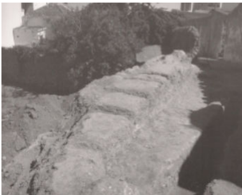
Figura 8 – Pormenor da barbaca da Rua Detrás dos Muros (Maia, 2006: 49).
