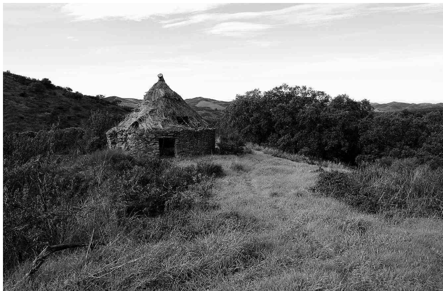
FIGURA 3. Palheiro de planta circular e cobertura em palha de centeio em Ebros.
