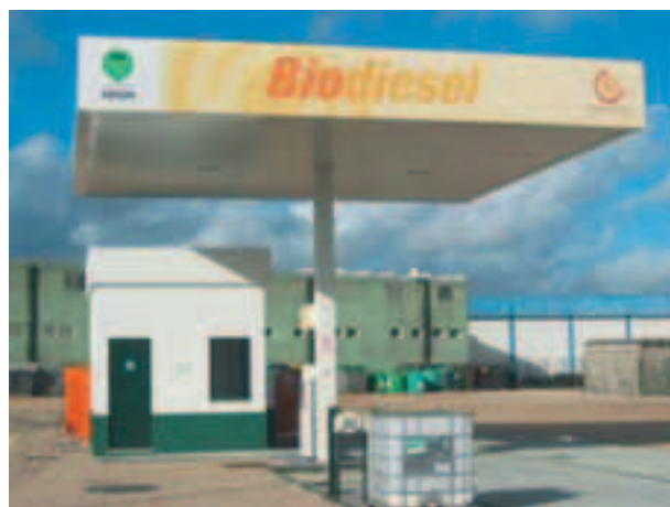
Figura 5.6.3: Posto de abastecimento
