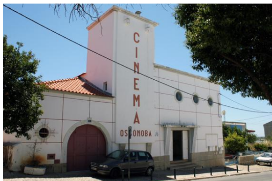
Fig. 11 – Edifício Cinema Ossónoba (2013)
