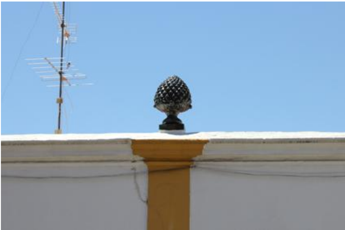
Imagem 95 – pormenor da platibanda (pinha) (2013)
