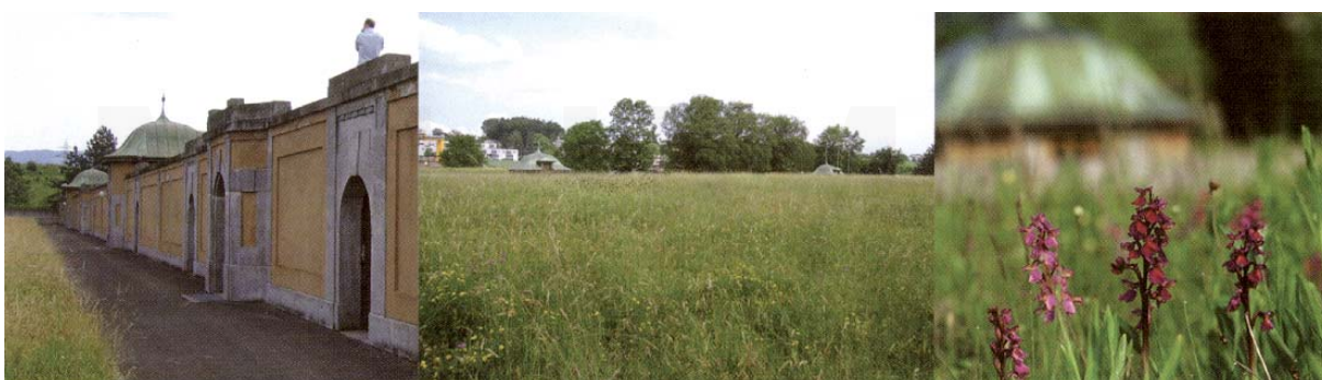
Figura 2.2.15. Reservatório de água. Basel. Suíça. Fonte: Werthemann,, 2007
