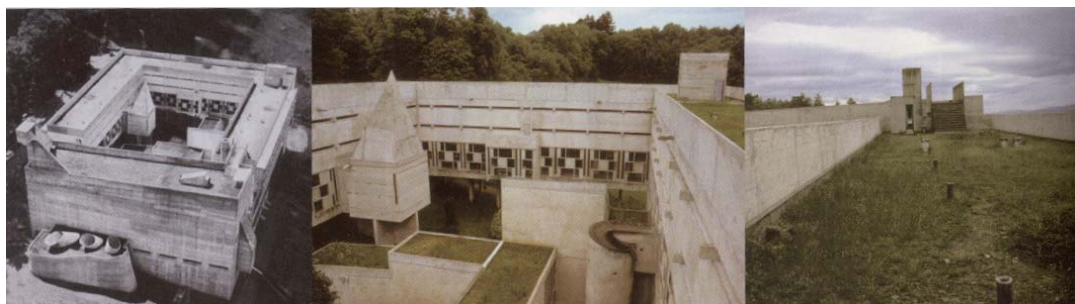
Figura 2.1.18. Mosteiro La Tourette. Le Corbusier. 1960 Eveux-sur-Arbresle. Lyon. França
