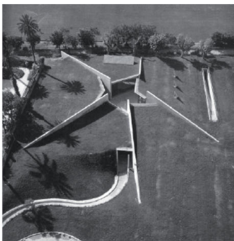
Figura 2.1.4. Centro Deportivo y de Salud, Carllós F. Lambarri, Barcelona, , 1993-96
