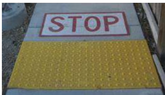
Figura 9. Marcação de pavimento “STOP”
