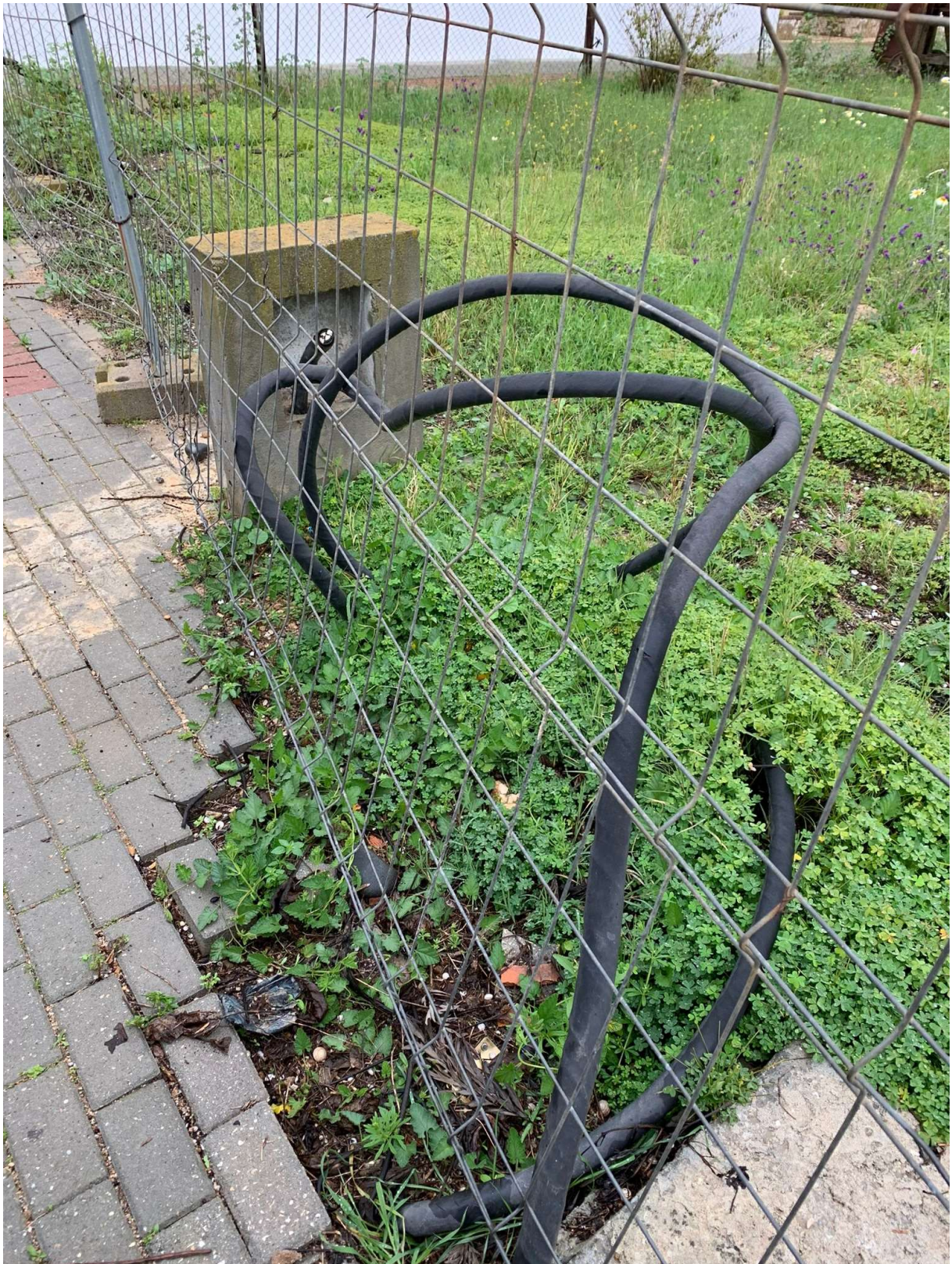
Figura 6: Foto 2, cabo existente lote 1 e 2.
