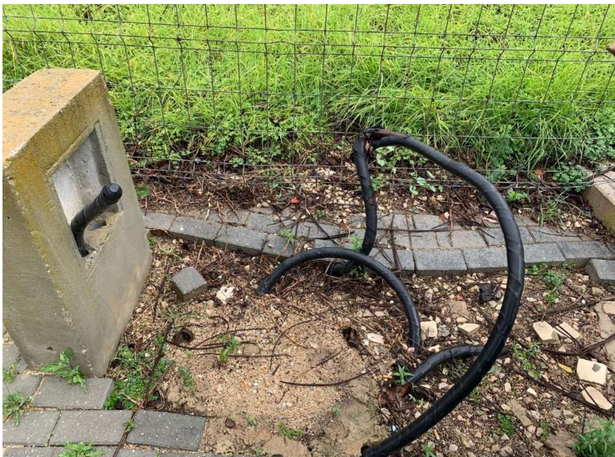
Figura 5: Foto 1, cabo existente lote 1 e 2.
