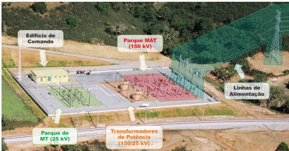
Figura 3.7 – Vista aérea da subestação de tração de Luzianes 1x25 kV AC [2].
